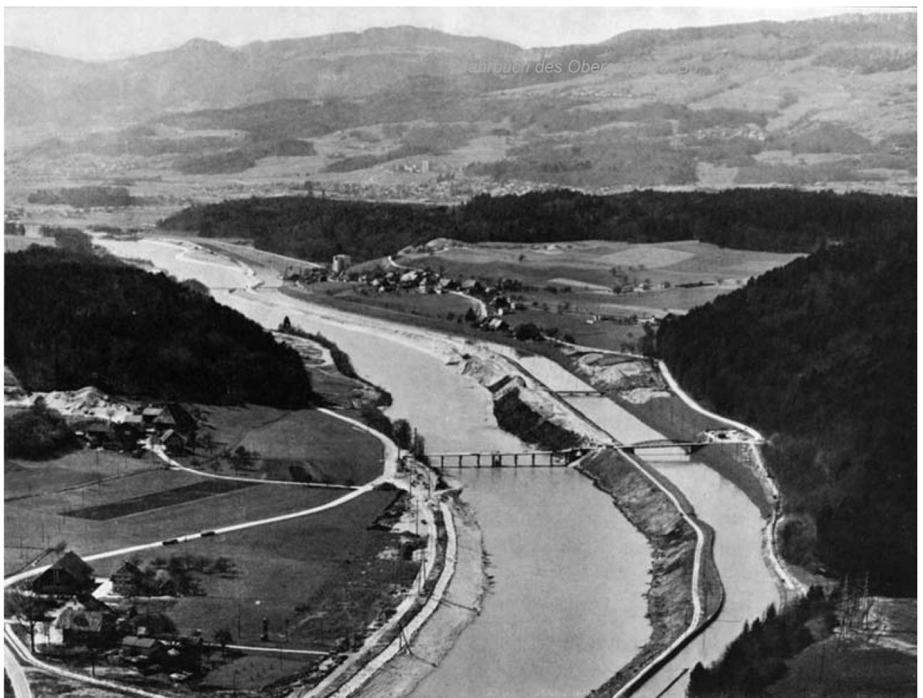
Blick aareaufwärts von Berken über Walliswil-Bipp und Wiedlisbach zum Jura. Uferbauten für neue Aarekraftwerk Bannwil der BKW. (Kanal heute zugeschüttet)
