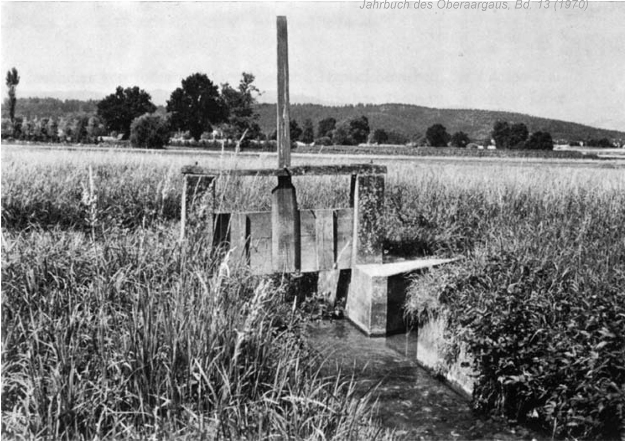
Eine «Brütsche» im Steiachgeraben. Je nach Wunsch wird hier das Wasser gestaut und durch die beidseitigen Ablisse auf die Matten geleitet. Aufn. Chr. Leibundgut
