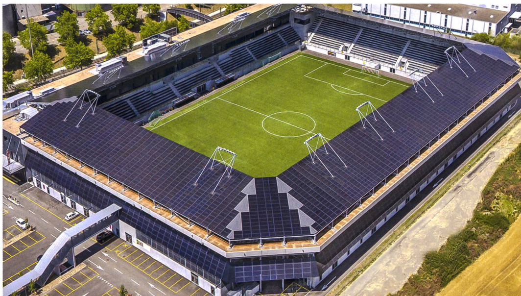
Abb. 2: Die in den LIPO-Park Schaffhausen integrierte 1,4 MWp starke Photovoltaikanlage des Elektrizitätswerks des Kantons Schaffhausen (EKS) ist die grösste stadionintegrierte Anlage der Schweiz und europaweit die grösste PlusEnergieBau-Anlage eines Fussballstadions (Stand Januar 2018). Sie erzeugt jährlich 1290 000 kWh Strom und deckt damit 150% des Gesamtenergiebedarfs des Stadions inklusive der Mantelnutzung mit Einkaufs-, Dienstleistungs- und Gewerbezentrum. Die Fussballarena LIPO-Park wurde bereits mehrfach ausgezeichnet - namentlich mit dem Europäischen Solarpreis, dem Schweizer Solarpreis sowie dem Norman Foster Solar Award-Diplom für eine ästhetisch vorbildliche PEB-Solararchitektur.
