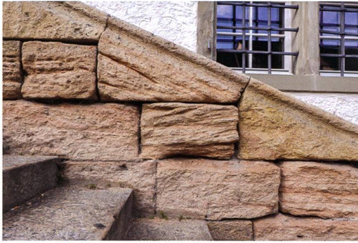
Abb. 105: Randengrobkalk vor dem Münster in Schaffhausen. Selbst im Baustein sind die Sedimentstrukturen gut erkennbar.
