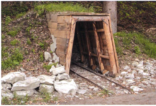
Abb. 21: In Oberwiesen bei Schleithelm wurde als Teil des Gipsmuseums ein «Mundloch» für den Gipsabbau rekonstruiert. Ein «Mundloch» bezeichnet in der Bergmannssprache den an der Tagesoberfläche liegenden Eingang eines Stollens.
