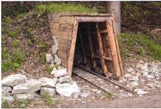
Abb. 21: In Oberwiesen bei Schleithem wurde als Teil des Gipsmuseums ein «Mundloch» für den Gipsabbau rekonstruiert. Ein «Mundloch» bezeichnet in der Bergmannssprache den an der Tagesoberfläche liegenden Eingang eines Stollens.
