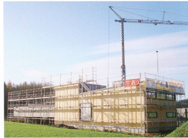
Der Baufortschritt am 8. Dez. 2011
