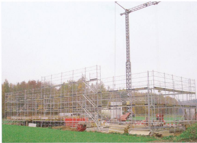
Die Sternwarte während dem Bau, hier am 7. Nov. 2011
