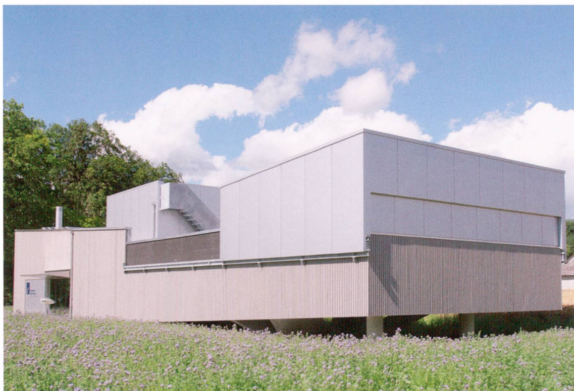
Die neue Sternwarte. Im Vordergrund ist das Observatorium mit dem waagrecht verschiebbaren Dach sichtbar
