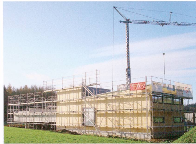
Der Baufortschritt am 8. Dez. 2011
