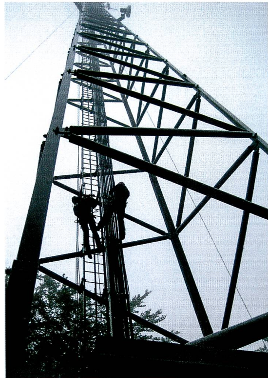
Die Höhenarbeiter installieren die Windmessgeräte am Antennenmast des Siblinger Randens auf 40 und 65 Metern über Boden.
