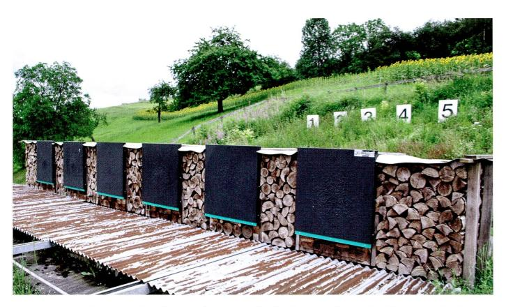
72 Künstliche Kugelfänge wie hier in Altorf verhindern, dass Blei aus der Munition in den Boden und schliesslich in die Nahrungskette gelangen kann.
