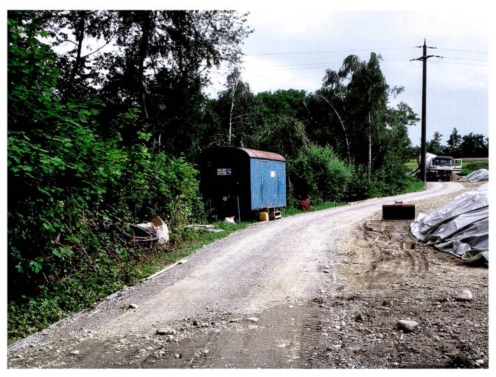
68 Schutz des Unterbodens durch eine Kiespiste, die den Druck der Baumaschinen auf eine breite Fläche verteilt.
