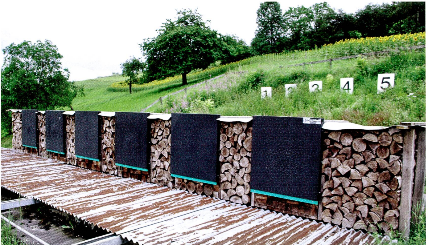
72 Künstliche Kugelfänge wie hier in Altorf verhindern, dass Blei aus der Munition in den Boden und schliesslich in die Nahrungskette gelangen kann.
