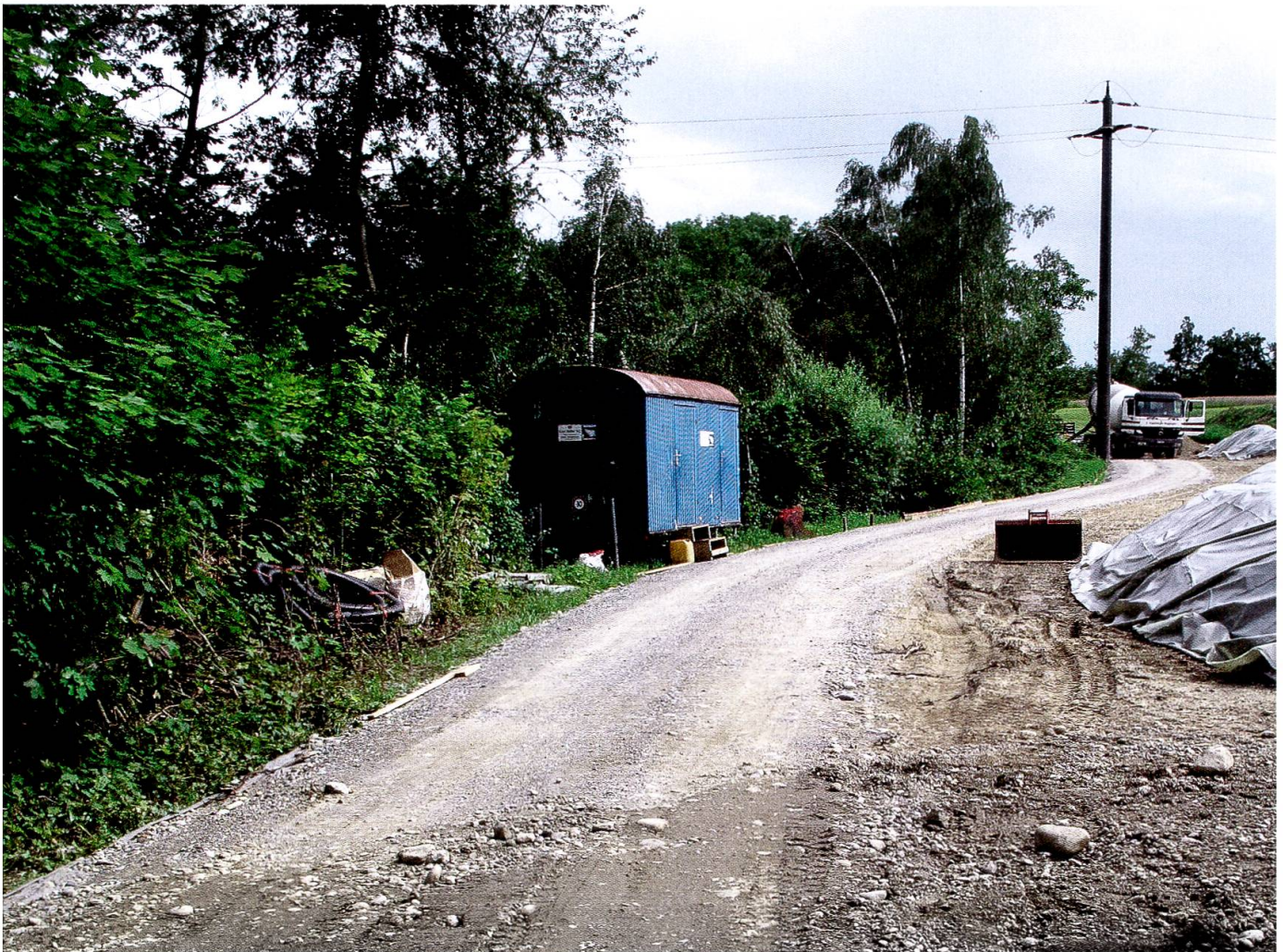
68 Schutz des Unterbodens durch eine Kiespiste, die den Druck der Baumaschinen auf eine breite Fläche verteilt.
