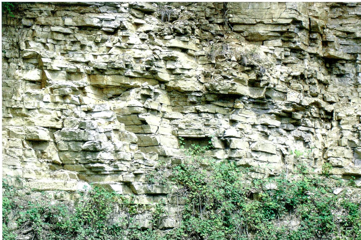
6 «Wohlgeschichtete Kalke» des Malm im ehemaligen Steinbruch westlich der «Tüfels-Chuchi» in Beringen
