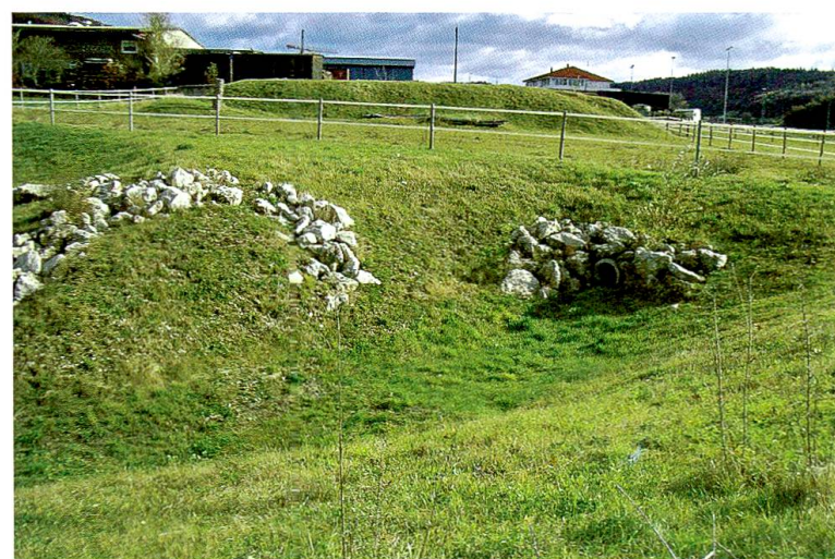
111 Versickerungsanlage Beringen, Industriezone West. Foto: ALU
