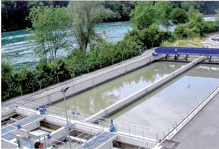
108 Vorklärbecken der ARA Röti (Erneuerung im Jahre 2006). Im Hintergrund der Vorfluter Rhein. Foto: ALU
