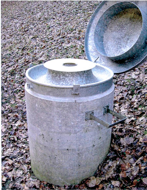
72 Trockeneinstieg Brunnenstube, geöffnet, mit Filterdeckel, 2008. Foto: ALU
