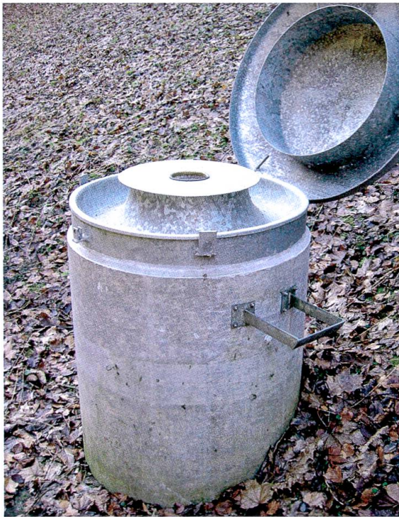
72 Trockeneinstieg Brunnenstube, geöffnet, mit Filterdeckel, 2008. Foto: ALU
