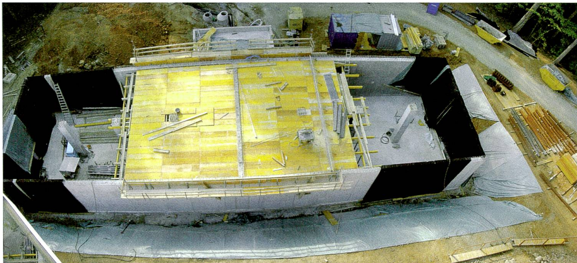
88 Wilchingen, Reservoir Schinderwase im Bau (1. Juli 2008). Foto: ALU
