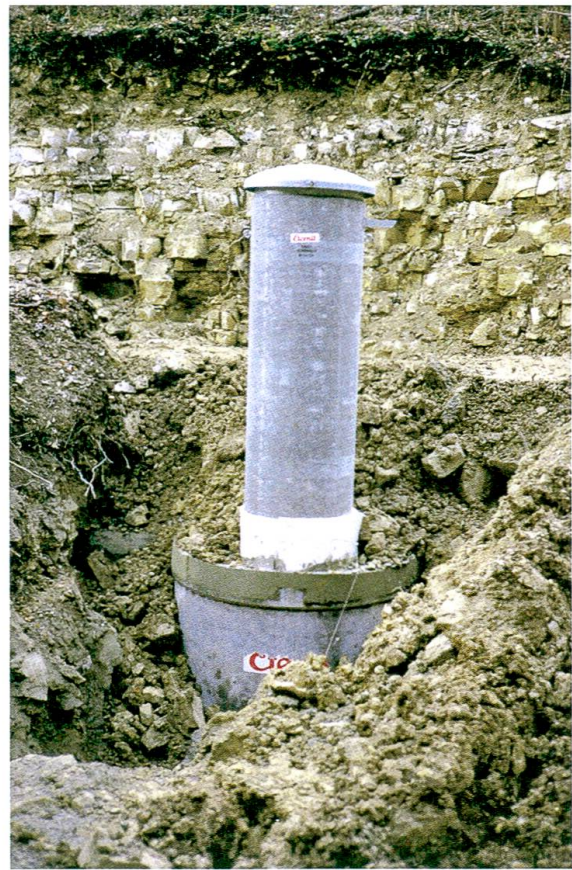
69 Quellfassung, Trockeneinstiegsröhre, Herbst 1989. Foto: ALU
