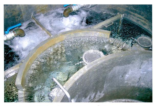
74 Brunnenstube mit Quelleinläufen, Beruhigungsbecken, Überlaufstutzen, Trinkwasserseiher und Trockeneinstieg (Vordergrund), Januar 2008. Foto: ALU
