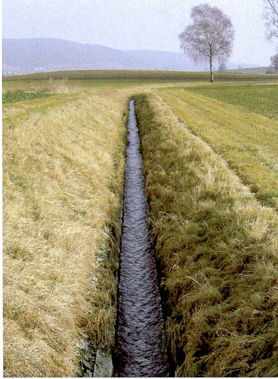
18 Kanalisierter Bach Neunkirch, Fochtelgraben. Foto: ALU
