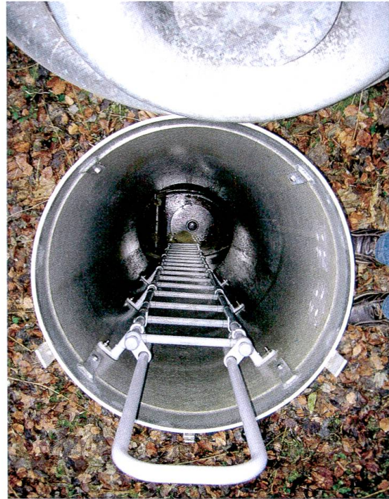
73 Trockeneinstieg Brunnenstube, Sicht auf den «trockenen» Boden, Januar 2008. Foto: ALU
