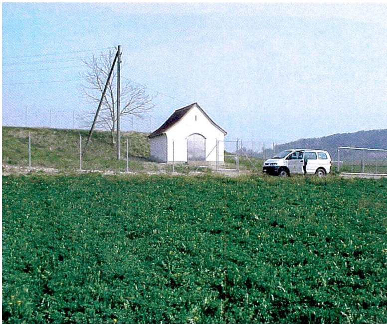
102 Schutzzone S3 korrekt eingezäunt. Foto: ALU
