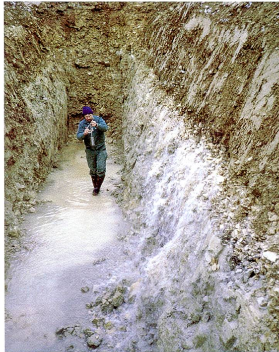
14 Wasserführende Schicht, sogenannter Quellhorizont. Beringen, Sanierung Chäserhalde SW-Graben 4. 3. 1987.
