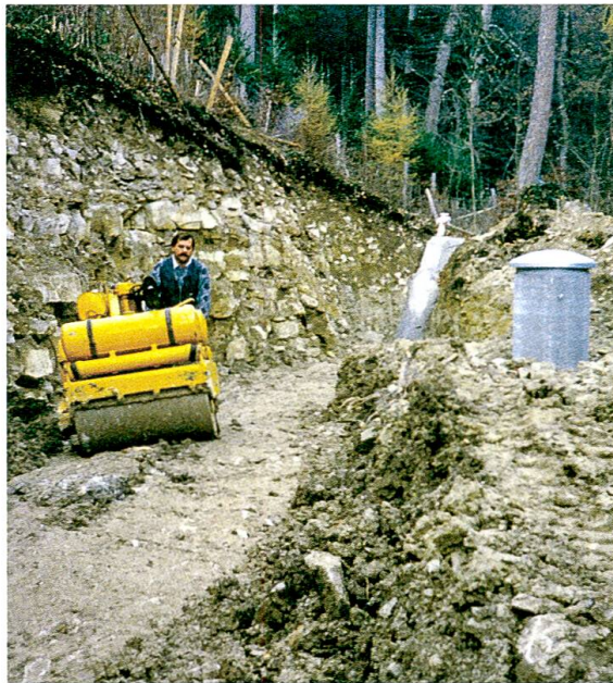
70 Abdecken der Quellfassung, Herbst 1989. Foto: ALU
