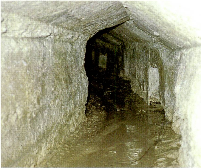
64 Alter Quelleinlauf (Fassungsstrang vor 1989). Foto: ALU
