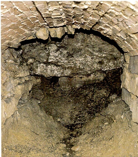
52 Alte Dorfbrunnen-Quellfassung Buebenhalde, Wilchingen. Foto: ALU
