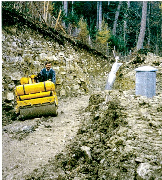
70 Abdecken der Quellfassung, Herbst 1989. Foto: ALU
