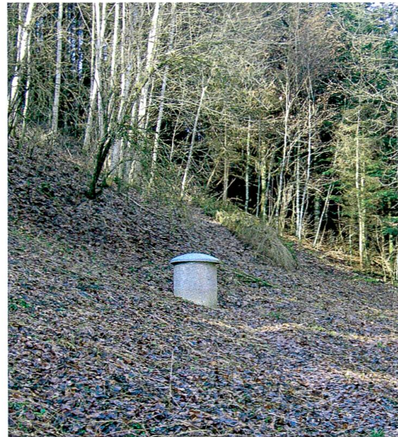
71 Trockeneinstieg Brunnenstube (nicht direkt über dem Trinkwasser), Januar 2008. Foto: ALU
