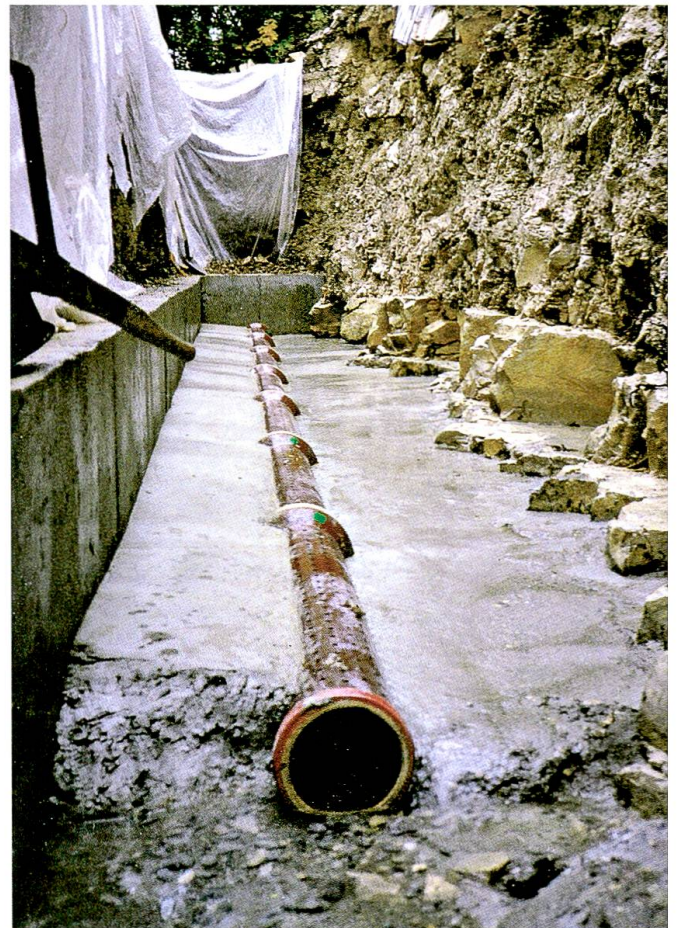
67 Quellhorizont rechts, mit Fassungsstrang und Rückstau- mauer links, Herbst 1989. Foto: ALU
