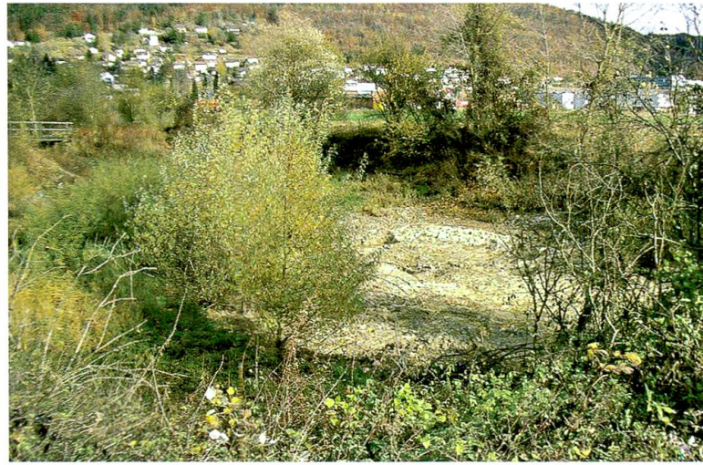
110 Versickerungsanlage Rossfähi Beringen.
