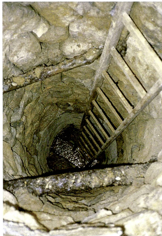
51 Sanierung Röhrenhalde, Beringen: Der mittlere Schacht ist ca. 6 m tief. Foto: ALU
