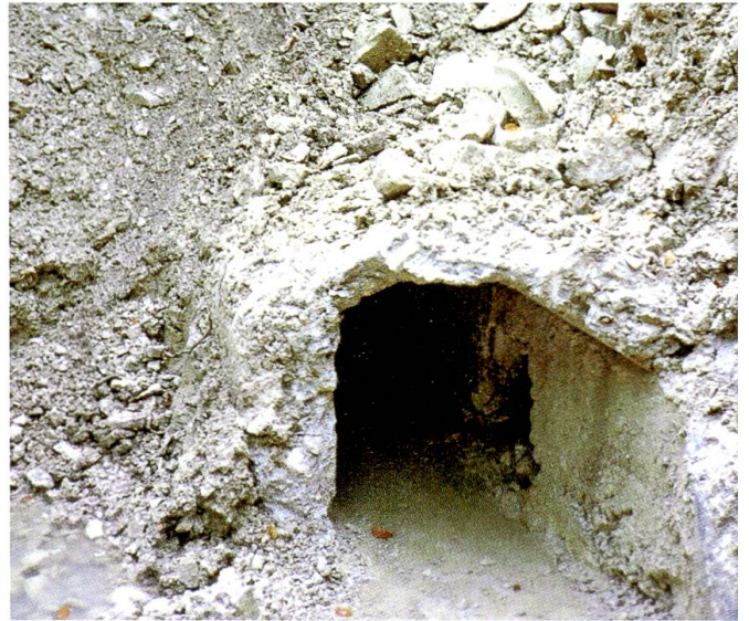
65 Alter Quelleinlauf (Fassungsstrang), Abriss Herbst 1989. Foto: ALU
