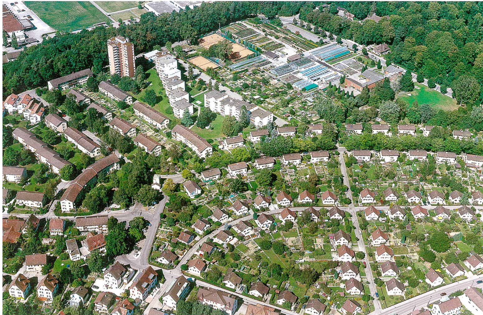
60 Die Eisenbahnersiedlung im Quartier Niklausen wird geprägt durch die grossflächigen und damit die ganze Siedlung auflockernden Gärten.
