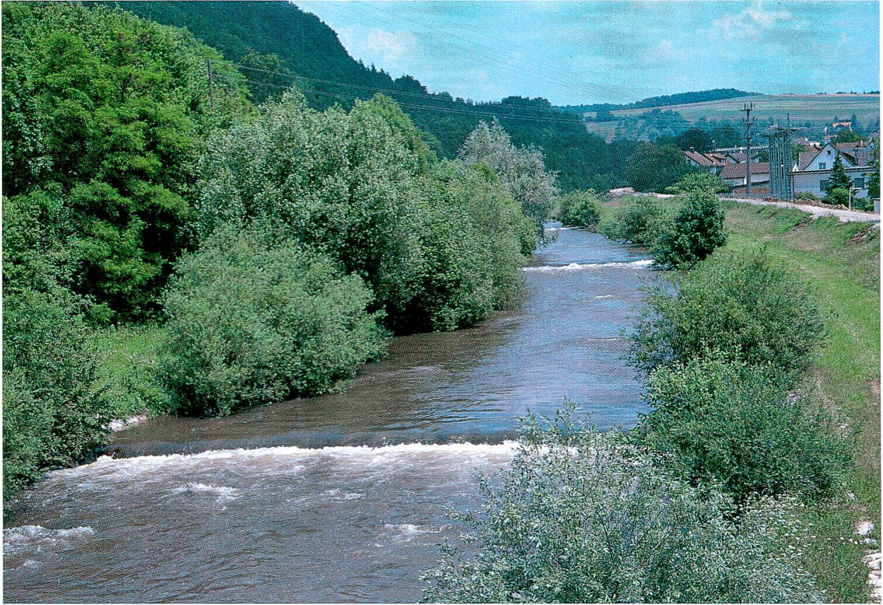
Abb. 43: Zahlreiche Schwellen brechen die Flusssynamik am Mittellauf.
