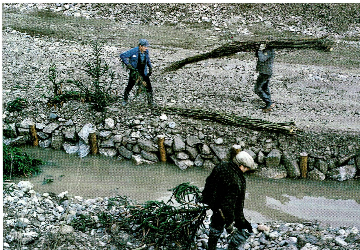
Abb. 40 und 41: Sicherungsmassnahmen im Winter 1977/78 am unterspülten Ufer bei Weizen. Die Eingriffe sind heute kaum mehr sichtbar.
