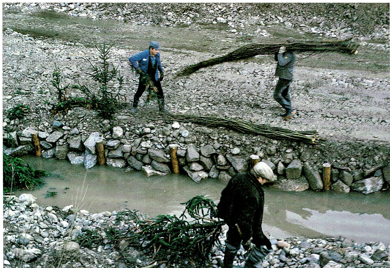
Abb. 40 und 41: Sicherungsmassnahmen im Winter 1977/78 am unterspülten Ufer bei Weizen. Die Eingriffe sind heute kaum mehr sichtbar.
