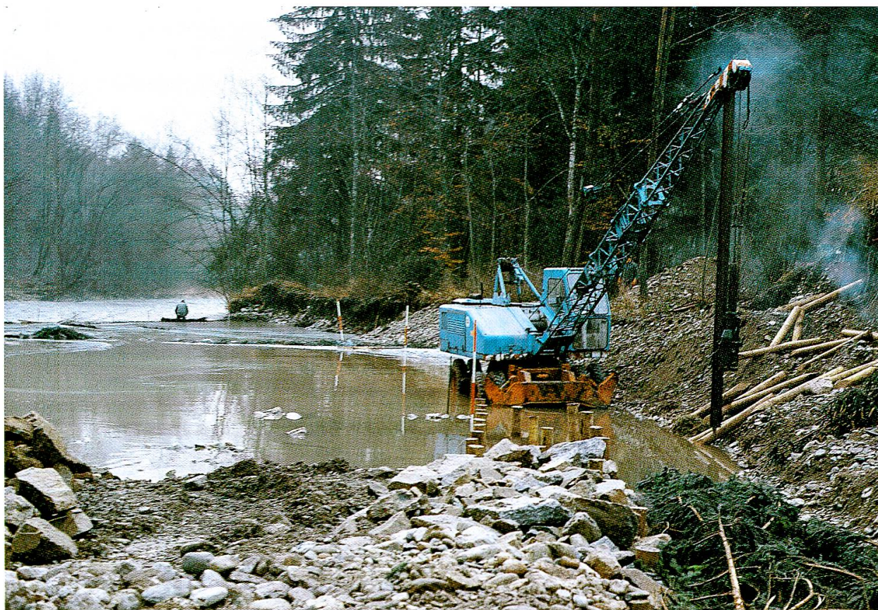
Abb. 40 und 41: Sicherungsmassnahmen im Winter 1977/78 am unterspülten Ufer bei Weizen. Die Eingriffe sind heute kaum mehr sichtbar.
