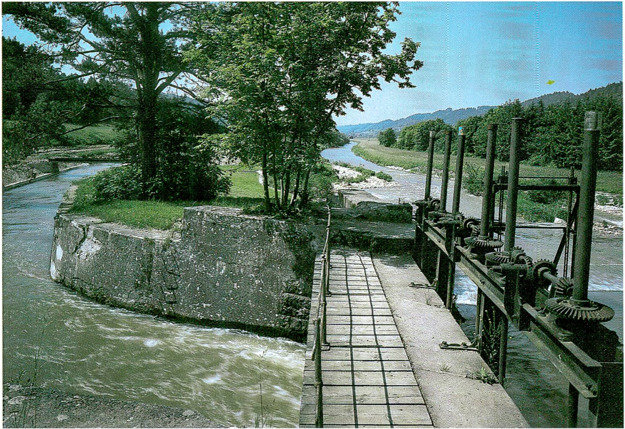
Abb. 35: Der Einlauf in den zum Kraftwerk Wunderklingen führenden Kanal.
