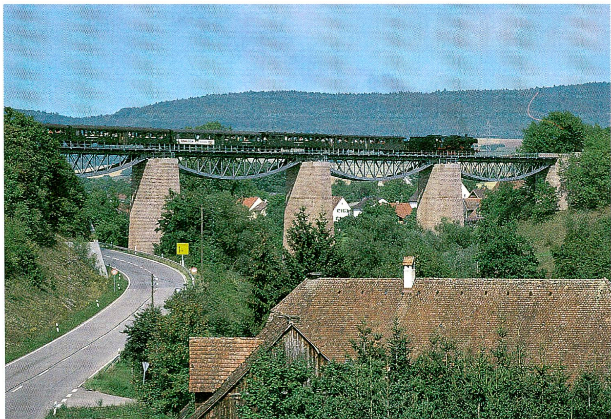
Abb. 19: Bei Fützen überspannt der 187 Meter lange Viadukt das Tal.
