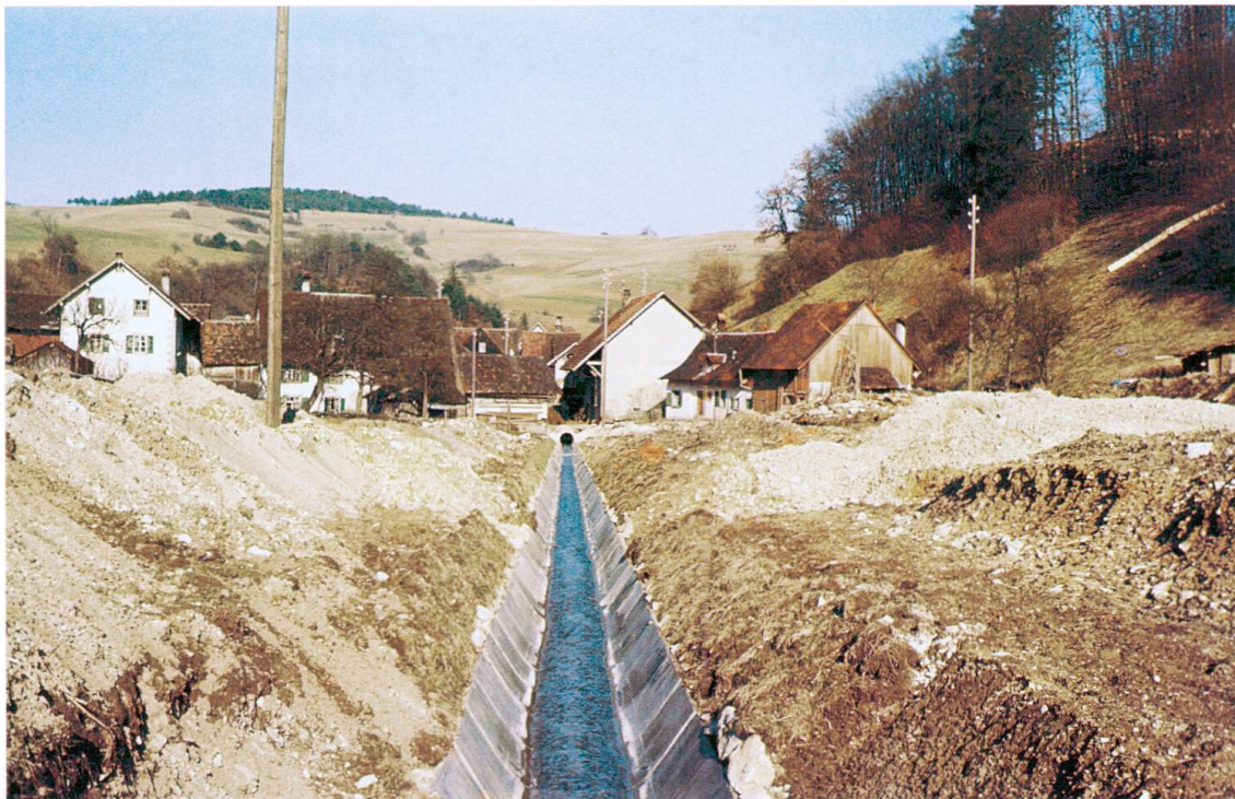
55 Melioration Barga 1956: Mülitalbach eingefasst, ab Dorfeingang eingedolt. Oberste Priorität hatte noch die Ausweitung der landwirtschaftlichen Produktionsfähigkeit.
