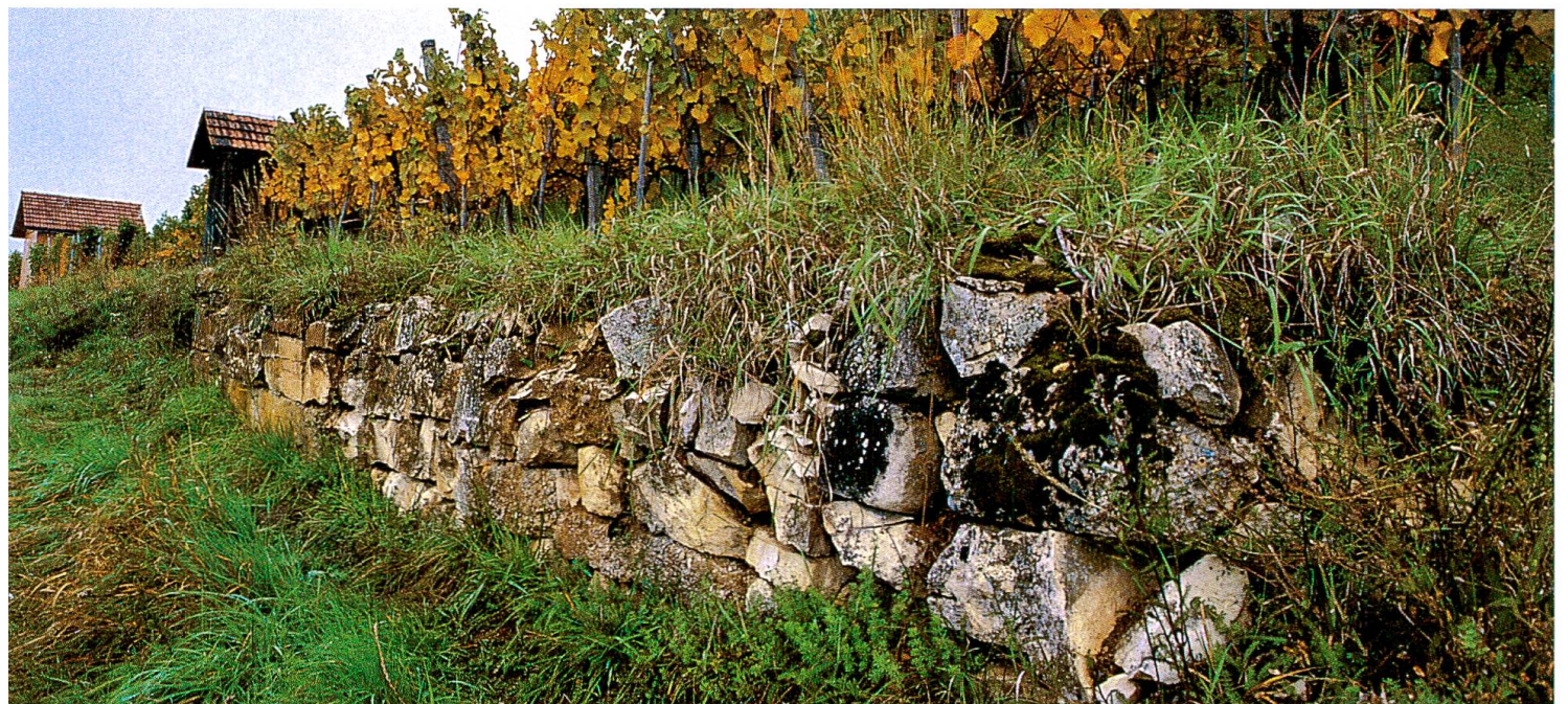
66 Steinmauer im Rebberg, Versteckmöglichkeiten für Zauneidechsen, Mauereidechsen und Schlingnattern
