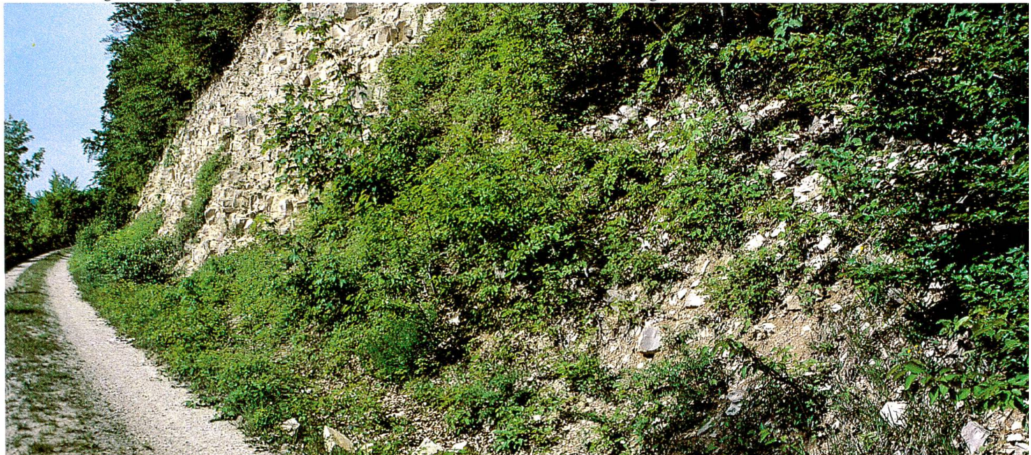
64 Ideale Wegböschung mit viel Steinpartien und unterschiedlicher Sonneneinstrahlung
