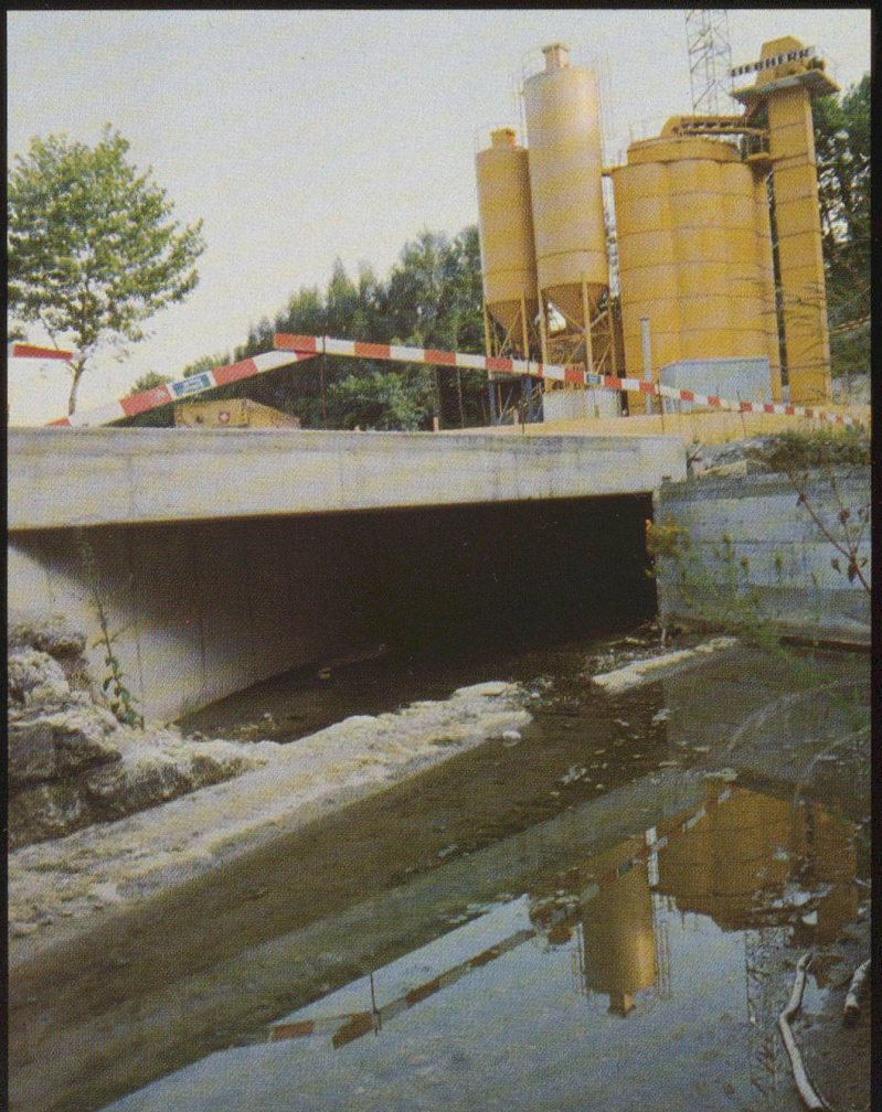
Abb. 24 Die Durach wird endgültig dem Bewusstsein der Stadtbewohner entzogen: Tunnelbaustelle der N 4 im vorderen Mühlental.
