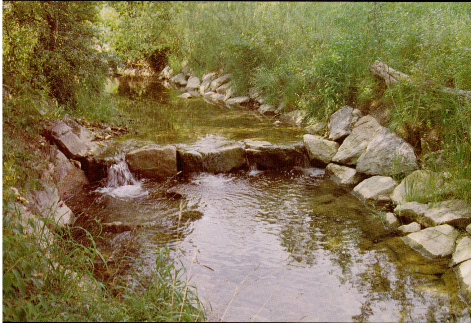
Abb. 14 Naturnahe Verbauung der Ufer mit Steinen
