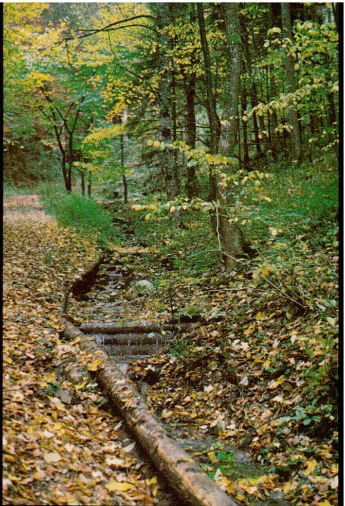
Abb. 9 Holzverbauungen unterhalb der Iblenquelle
