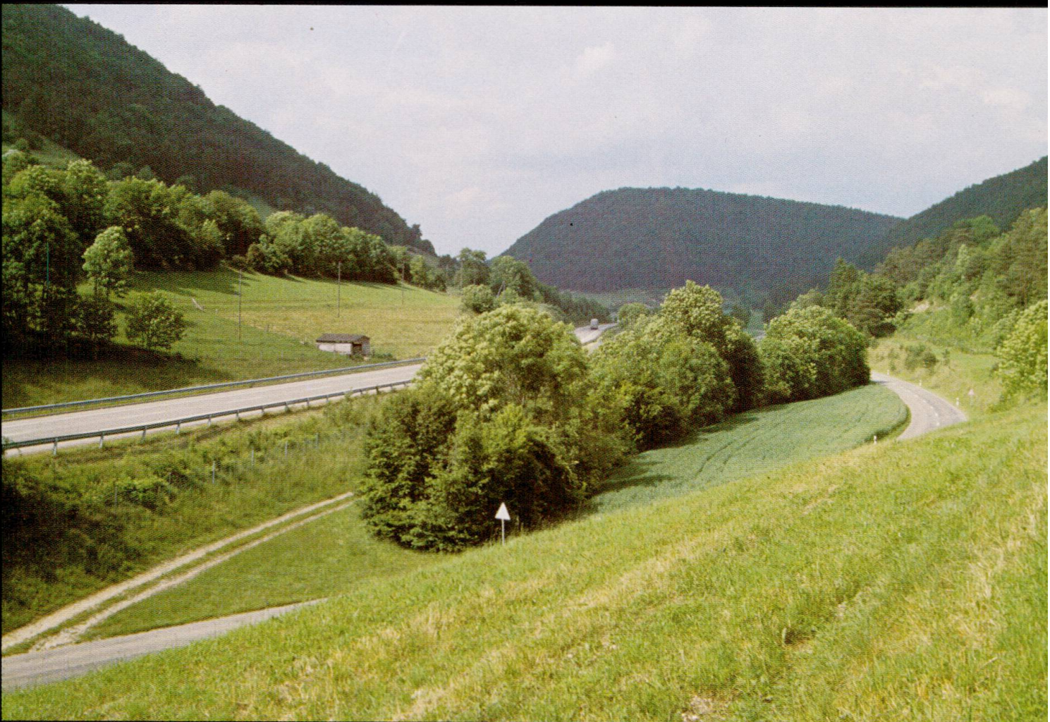
Abb. 11 Die Durach eingengt zwischen Strassen
