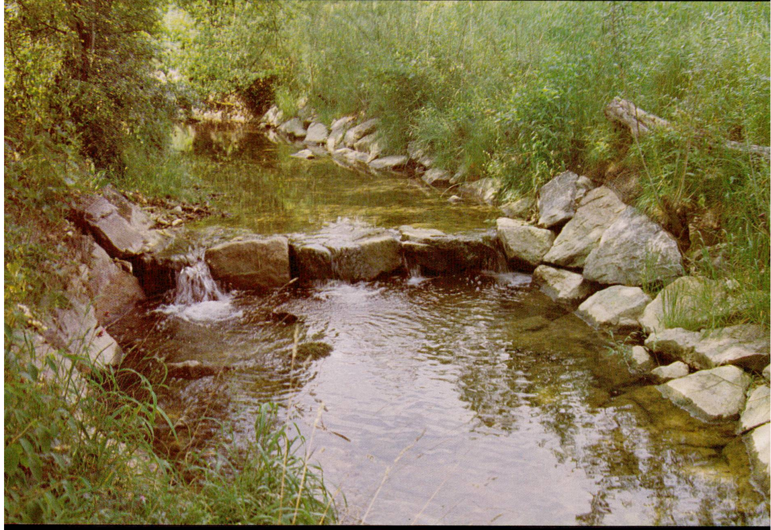
Abb. 14 Naturnahe Verbauung der Ufer mit Steinen
