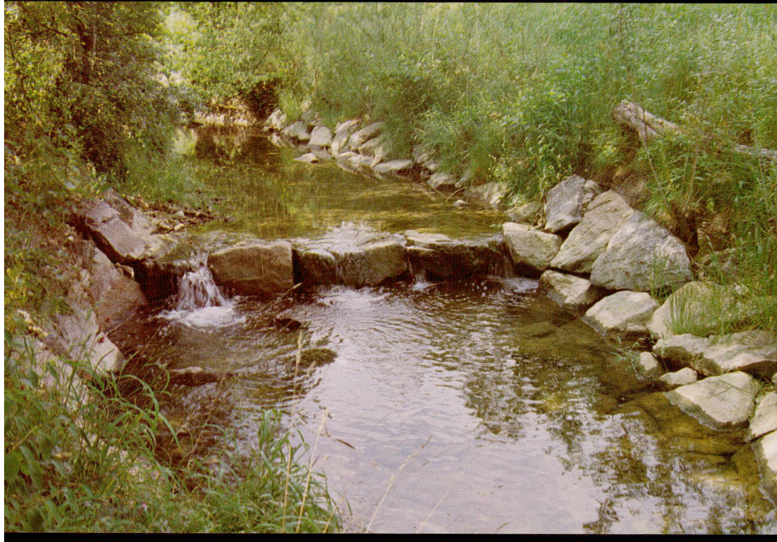
Abb. 14 Naturnahe Verbauung der Ufer mit Steinen
