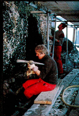
Abb. 17 Manuelle Säuberung von losem Gestein und Algen
