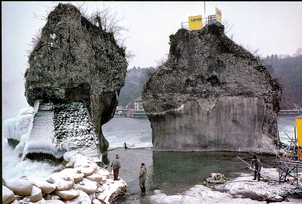
Abb. 20 100jährige Vormauerung am kleinen, Sanierung 1985 am grossen Felsen
