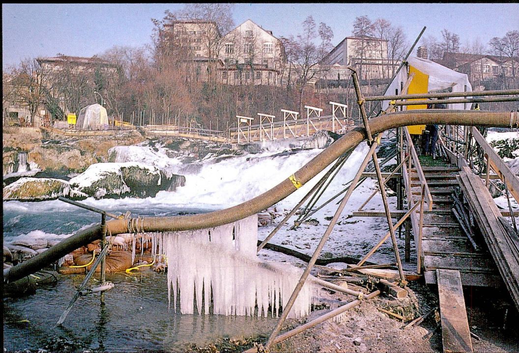
Abb. 16 Spritzbetontransportleitung vom Neuhauser Ufer aus
