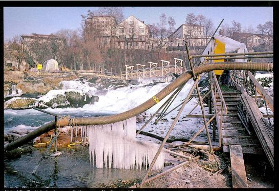
Abb. 16 Spritzbetontransportleitung vom Neuhauser Ufer aus
