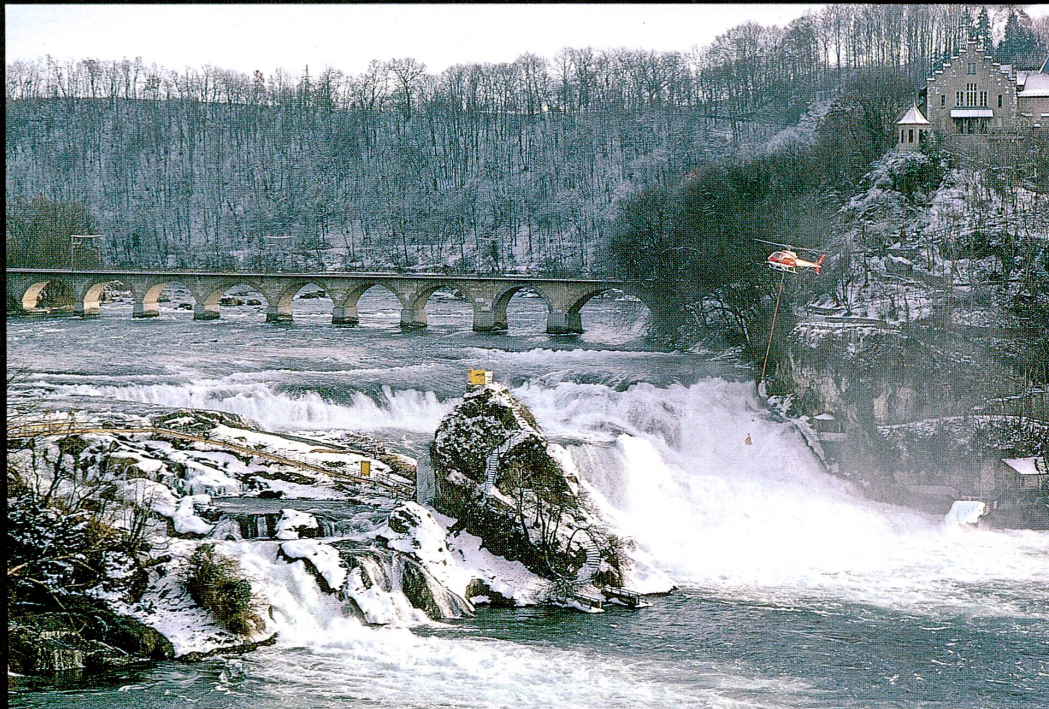
Abb. 13 2. Helikoptereinsatz zur Verstärkung der Sandsackdämme
