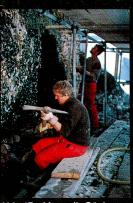
Abb. 17 Manuelle Säuberung von losem Gestein und Algen
