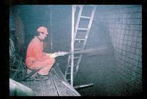
Abb. 19 Auftrag Spritzbeton
