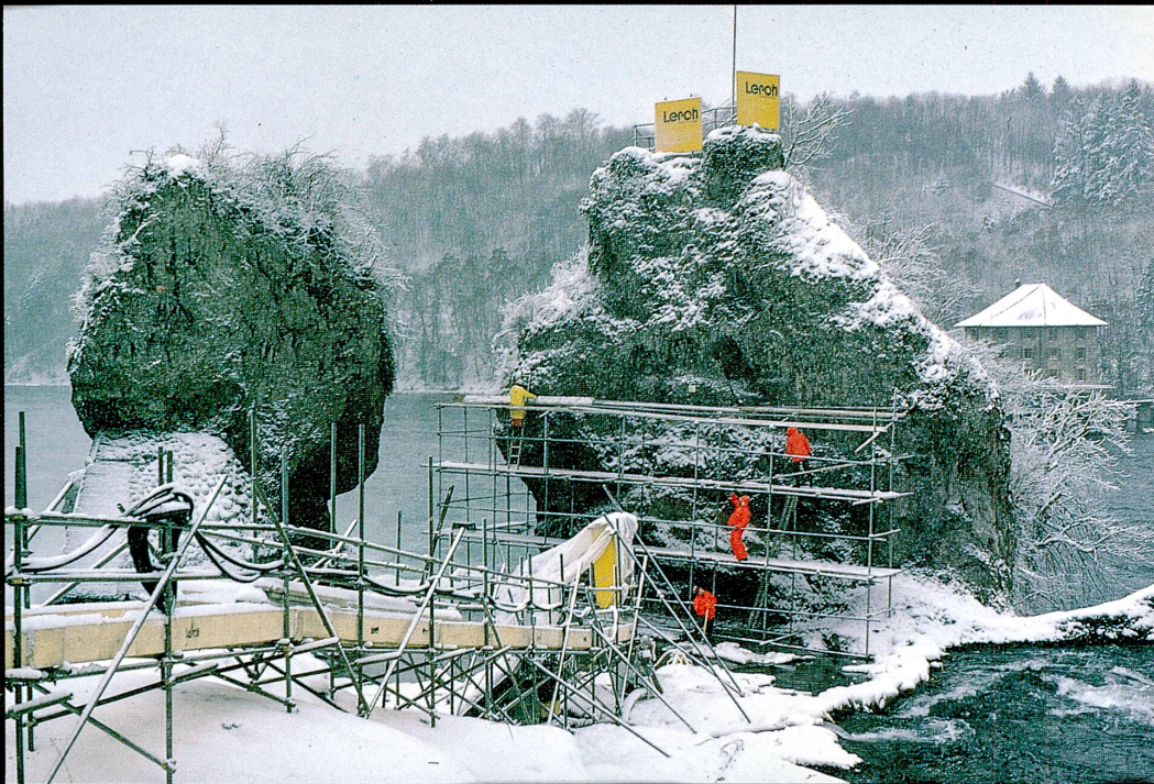
Abb. 10 Bau von Steg und Arbeitsgerüst
