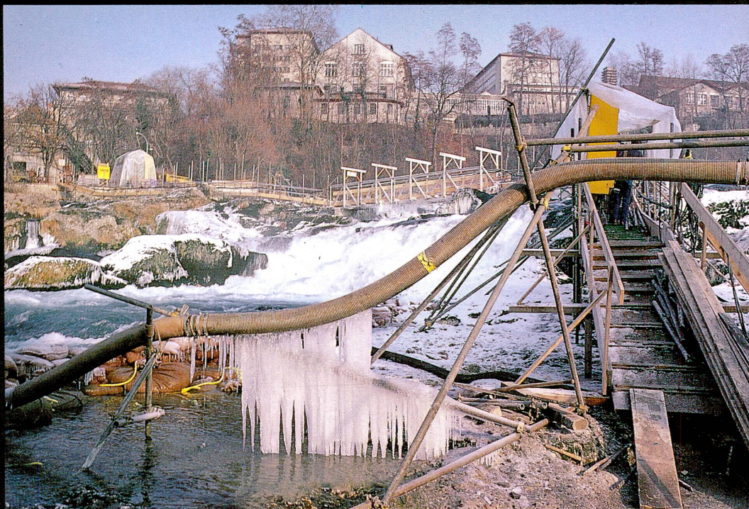
Abb. 16 Spritzbetontransportleitung vom Neuhauser Ufer aus
