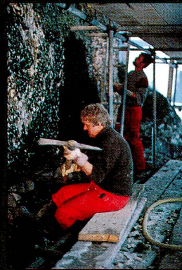
Abb. 17 Manuelle Säuberung von losem Gestein und Algen
