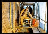
Abb. 18 Verfüllen der Klüfte mittels Injektionen
