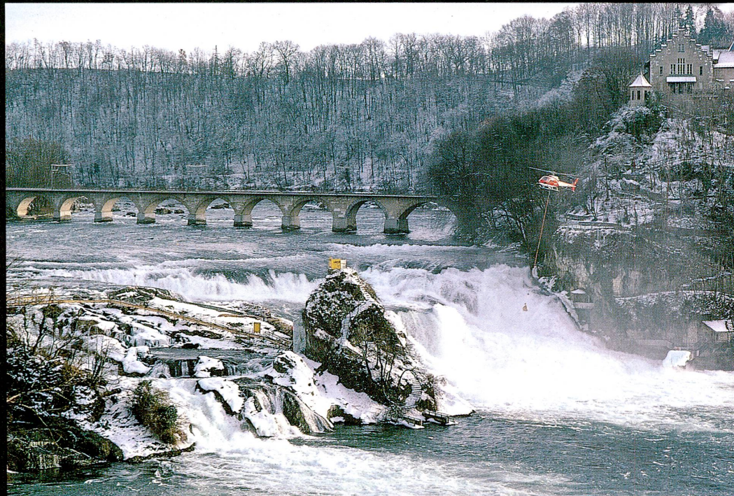
Abb. 13 2. Helikoptereinsatz zur Verstärkung der Sandsackdämme
