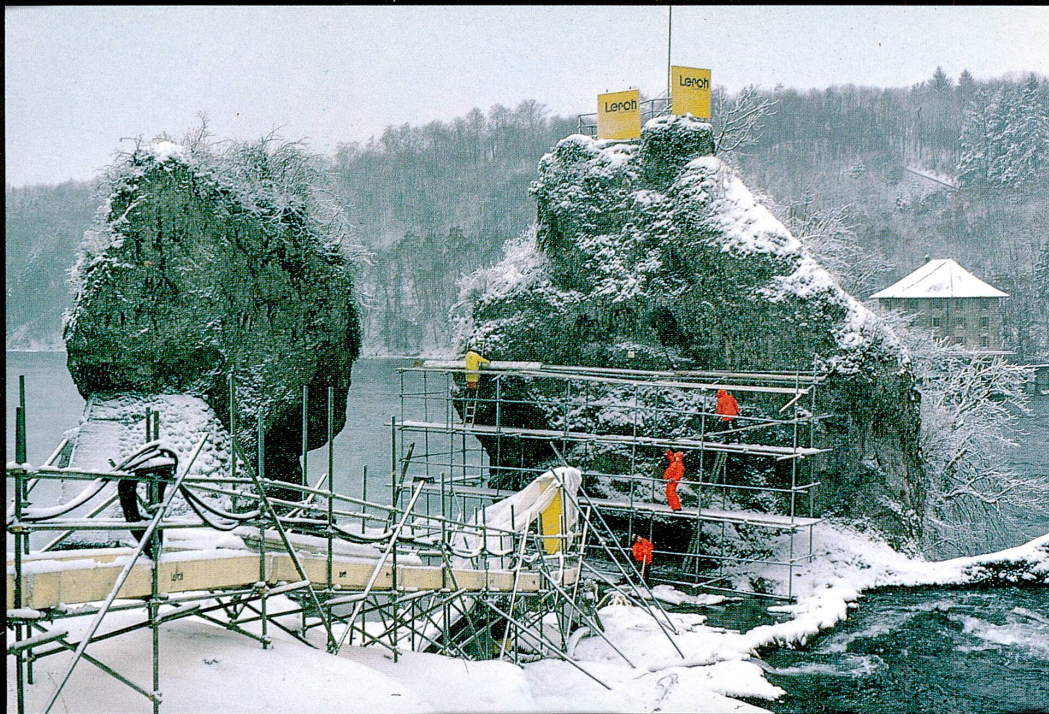
Abb. 10 Bau von Steg und Arbeitsgerüst
