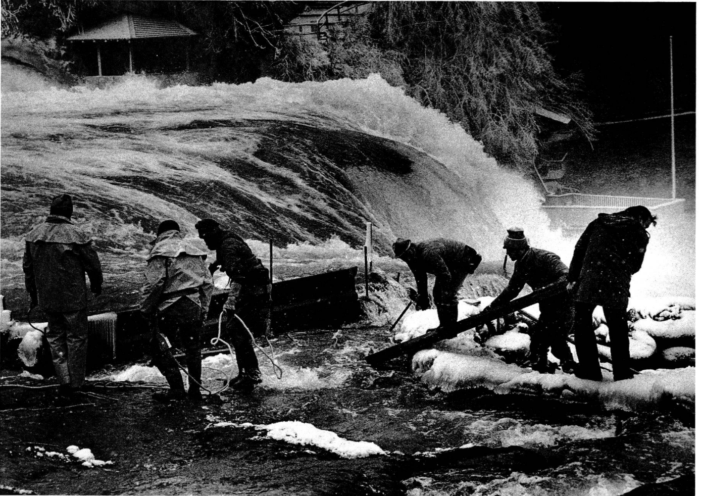
Abb. 9 Eiserner Schutzschild als Wellenbrecher
