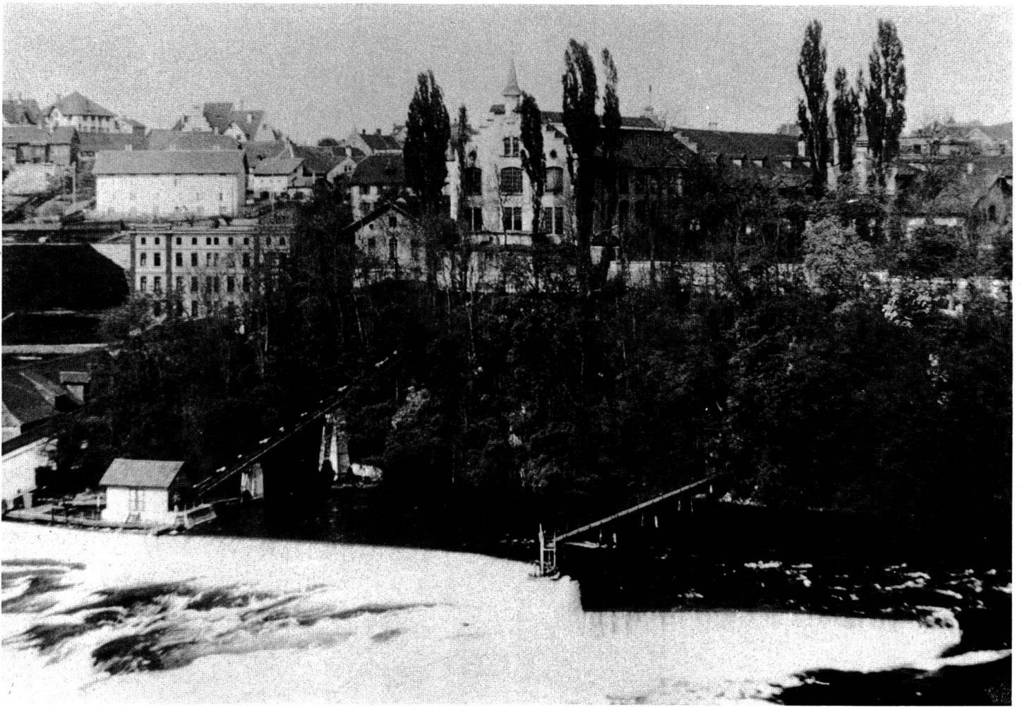
Abb. 26 Schiefliegende Welle zu den Fabrikgebäuden der SIG
