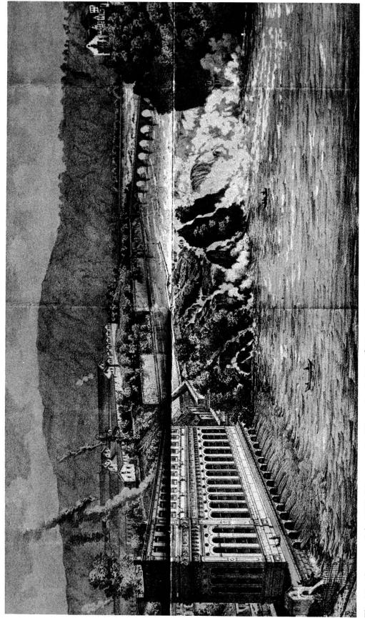
Fig. 12 Grossprojekt 1886: Nutzung der Wasserkraft (75 m³/s) zur Herstellung von Aluminium.
