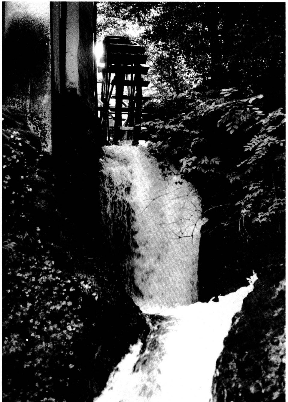
Abb. 25 Mühlekanal, ausgebaute Erosionsrinne
