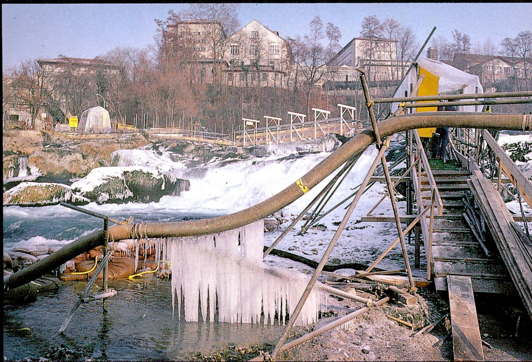
Abb. 16 Spritzbetontransportleitung vom Neuhauser Ufer aus
