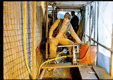
Abb. 18 Verfüllen der Klüfte mittels Injektionen
