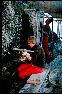
Abb. 17 Manuelle Säuberung von losem Gestein und Algen
