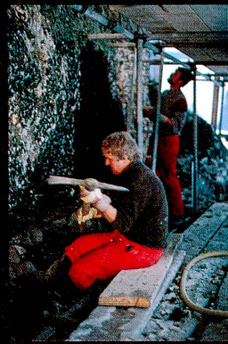
Abb. 17 Manuelle Säuberung von losem Gestein und Algen
