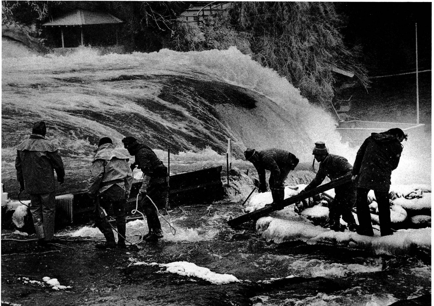
Abb. 9 Eiserner Schutzschild als Wellenbrecher
