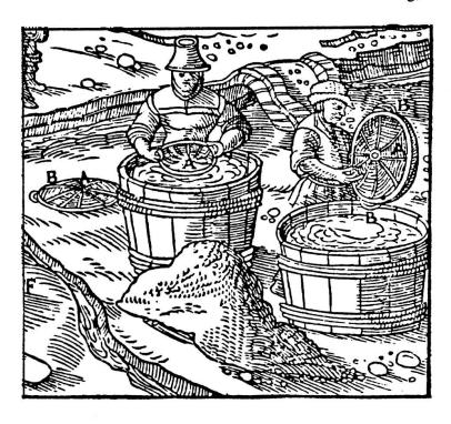
Fig. 13 Erzwaschen mit Waschsieb in Standen, aus: Agricola, 1556 (siehe auch Abb. 15).
