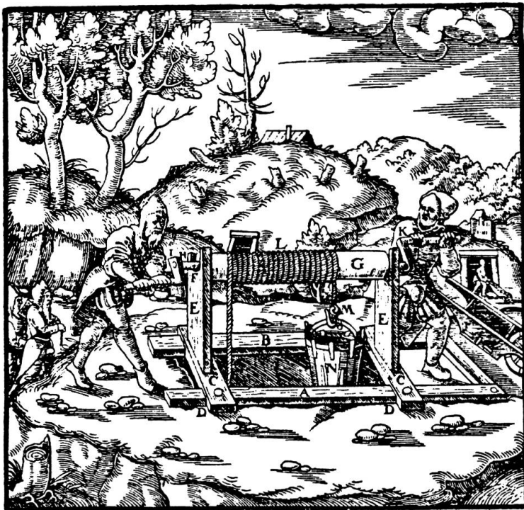
Fig. 12 Eine Schachtanlage, aus: Agricola, 1556 (siehe auch Abb. 12).
