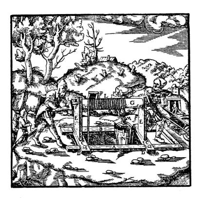
Fig. 12 Eine Schachtanlage, aus: Agricola, 1556 (siehe auch Abb. 12).
