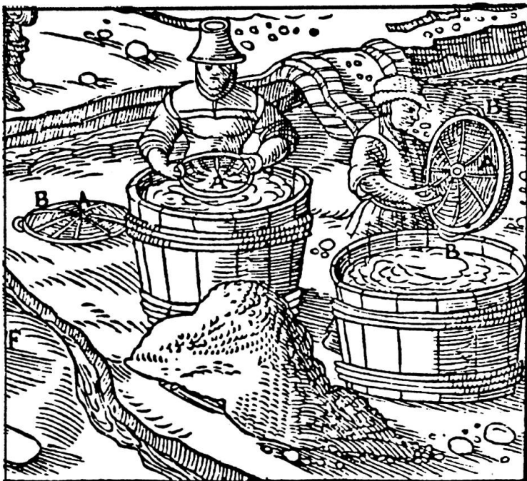
Fig. 13 Erzwaschen mit Waschsieb in Standen, aus: Agricola, 1556 (siehe auch Abb. 15).
