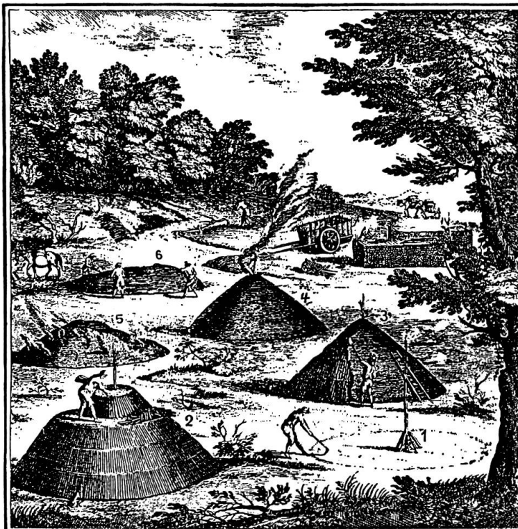
Fig. 28 Herstellung eines Kohlenmeilers, 18. Jh.
