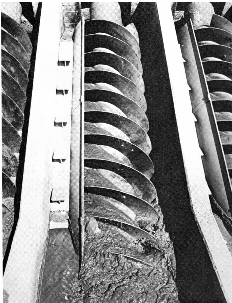
Mit Schneckenpumpen wird der biologische Schlamm in die Belüftungsbecken zurückgebracht.
