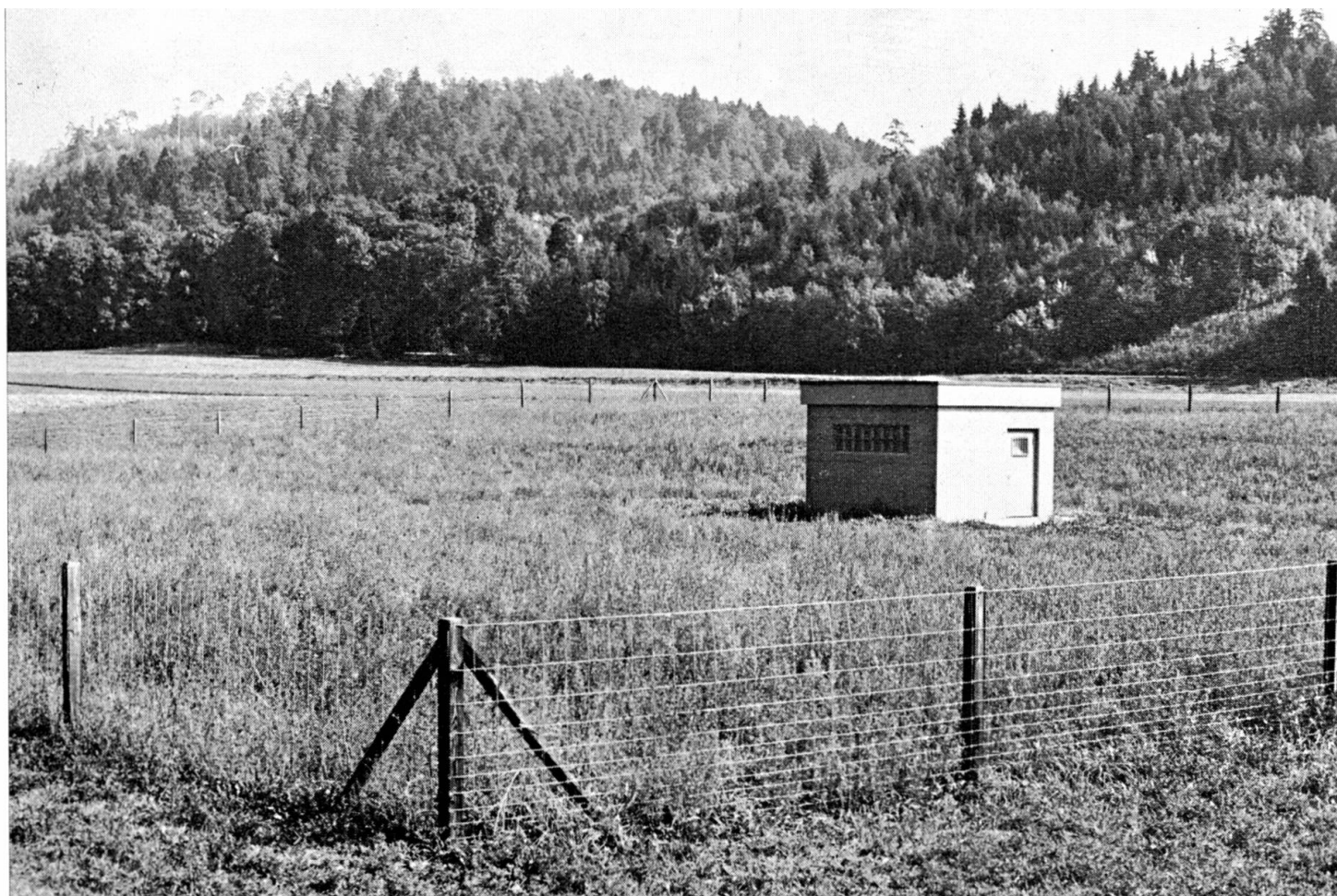
Das neue Grundwasserpumpwerk der Gemeinde Hallau liegt an der Wutach und ist durch eine umzäunte Zone vor jeglicher Oberflächenverschmutzung ideal geschützt.
