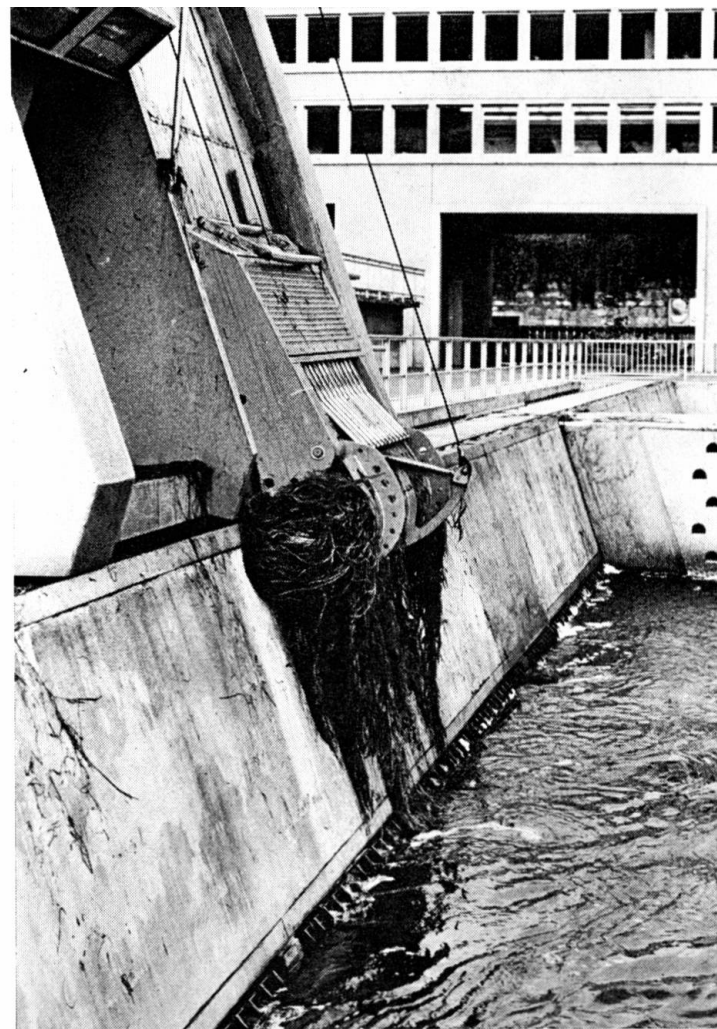
Im Hochsommer 1971 beliefen sich die Schlammanschwemmsel am Rechen des Kraftwerkes Schaffhausen täglich auf mehrere Lastwagenladungen.
