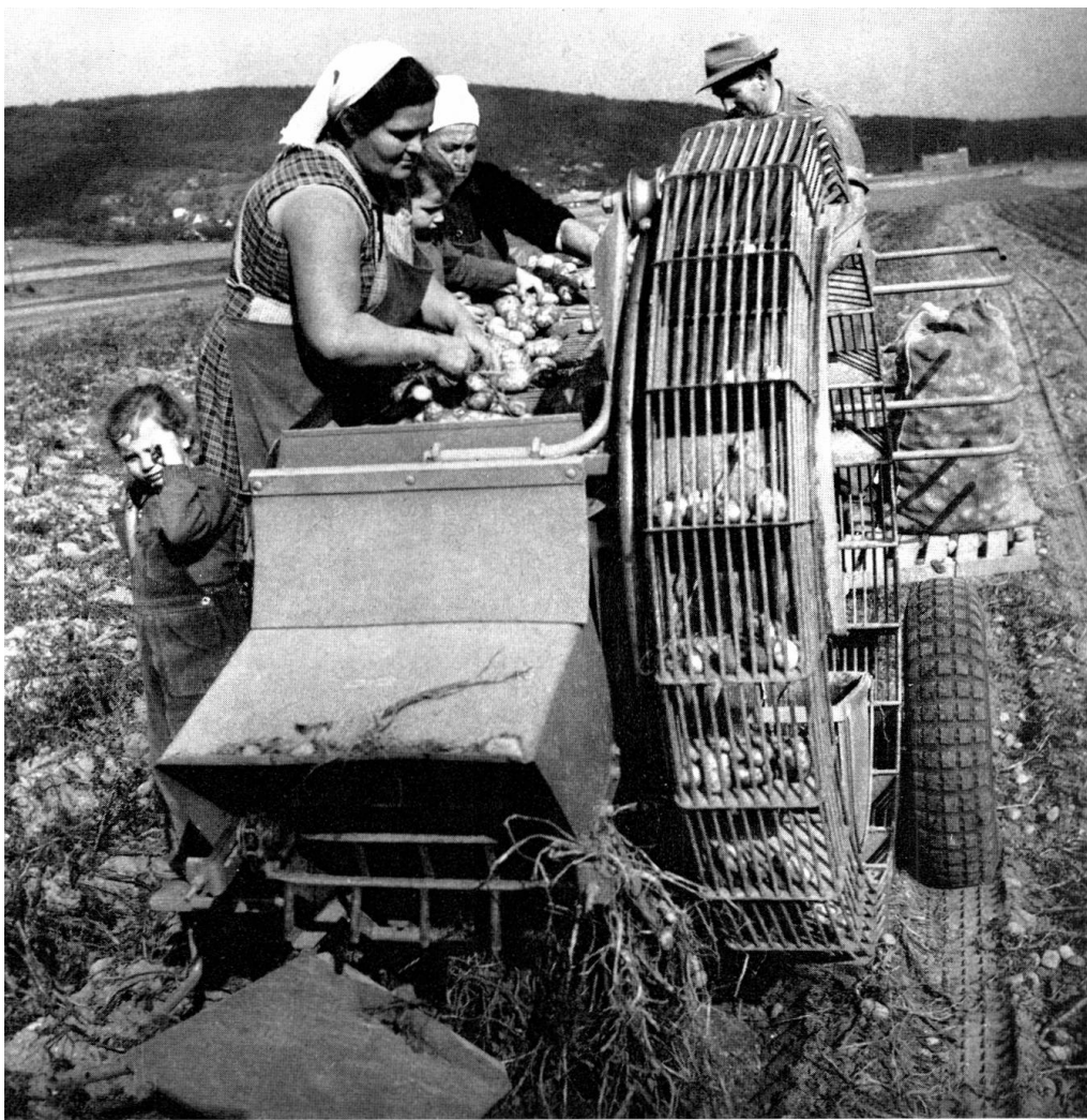
63. Bei Löhnigen 1962. Der «Wisent» gräbt die Knollen aus und füllt sie in Säcke ab, die vorn auf einer Bühne aufgestellt werden. Frauenhände lesen Steine und Erdschollen heraus. Nach einer Zeile fährt der Bauer zum Brückenwagen, wechselt die Säcke auf gleicher Ebene hinüber und nimmt wieder eine neue in Angriff.
