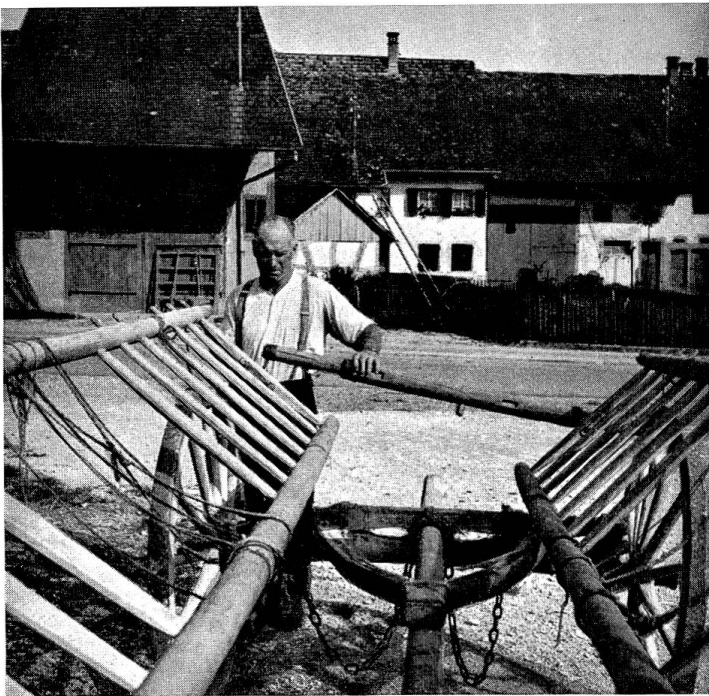
21. Einsetzen der Welle. Die Leitern liegen auf dem Achsenstock, die Grätzelarme auf dem Langbaum («Landwid») auf. Mit der Kette bindet man die Leiterbäume fest.
