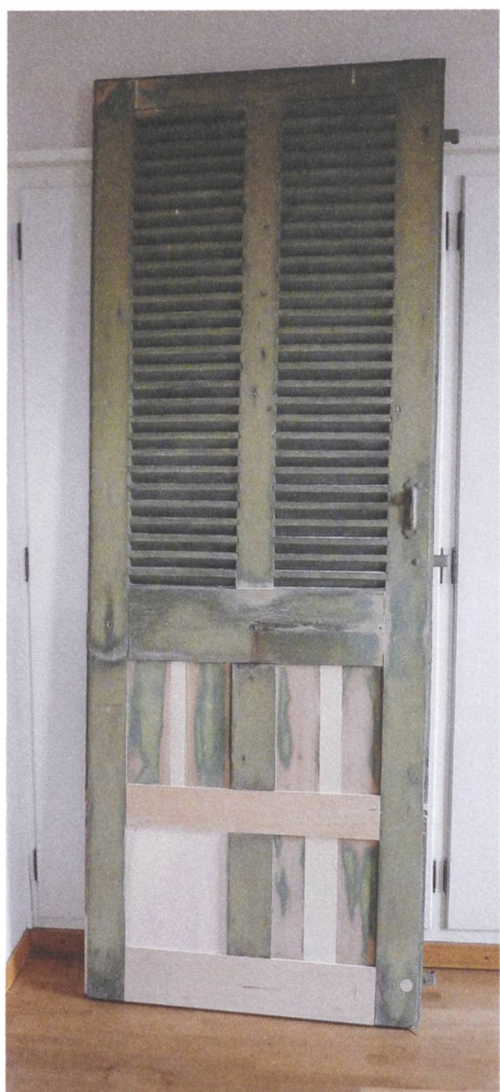
Heute werden defekte Bauteile in der Regel ganz ersetzt, auch wenn sie nur einen reparierfähigen Schaden aufweisen. Seltenes Beispiel für eine Reparatur eines hölzernen Klappladens. © Eva Schäfer
