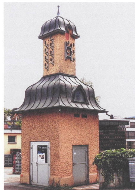
Abb. 2: Eines der Resultate des EKZ-Architekturwettbewerbs von 1909 steht im Schwyzer Freienbach. Es handelt sich um einen Flaschentrafo Typ 826 von 1911. © Yvonne Scheiwiller
