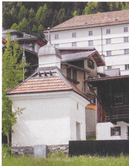
Abb. 8: Häufig wurden Trafos in der Form einer Kapelle gebaut. Im Kapellentrafo unterhalb des mächtigen Klosters Disentis ist heute ein Verteilkasten der Repower untergebracht. Gut erkennbar sind die drei Isolatoren, die verdeutlichen, dass hier keine Kapelle ist. © Yvonne Scheiwiller
