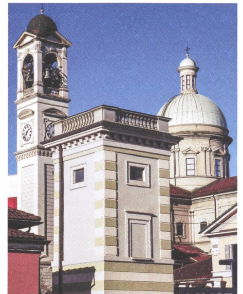
Abb. 9: Die Trafostation «Asilo» in der Nähe des Bahnhofs Chiasso ist in italienischer Neorenaissance 1919 durch die Azienda elettrica comunale di Chiasso erbaut worden. Sie harmonisiert hervorragend mit den historischen Kirchen im Hintergrund. © Yvonne Scheiwiller
