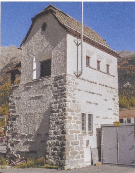
Abb. 7: Typisches Schalthaus der Rhätischen Bahn in Zernez. Architekt Meinrad Lorenz entwarf es 1913. Lorenz setzte traditionelle Bautechnik für moderne Gebäude ein: Seine Engadiner Hausteinarchitektur mit Trichterfenstern wird mit Pietra-rasa-Technik kombiniert. Rechts sieht man das Nachfolgemodell: Die Schaltanlage findet heute in einer grauen Kiste Platz. © Yvonne Scheiwiller
