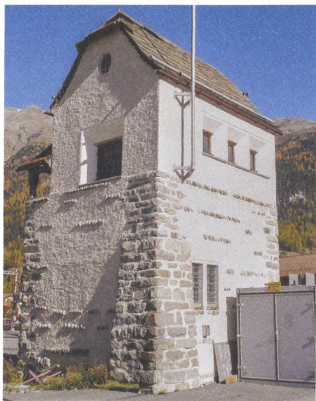
Abb. 7: Typisches Schalthaus der Rhätischen Bahn in Zernez. Architekt Meinrad Lorenz entwarf es 1913. Lorenz setzte traditionelle Bautechnik für moderne Gebäude ein: Seine Engadiner Hausteinarbeit mit Trichterfenstern wird mit Pietra-rasa-Technik kombiniert. Rechts sieht man das Nachfolgemodell: Die Schaltanlage findet heute in einer grauen Kiste Platz. © Yvonne Scheiwiller
