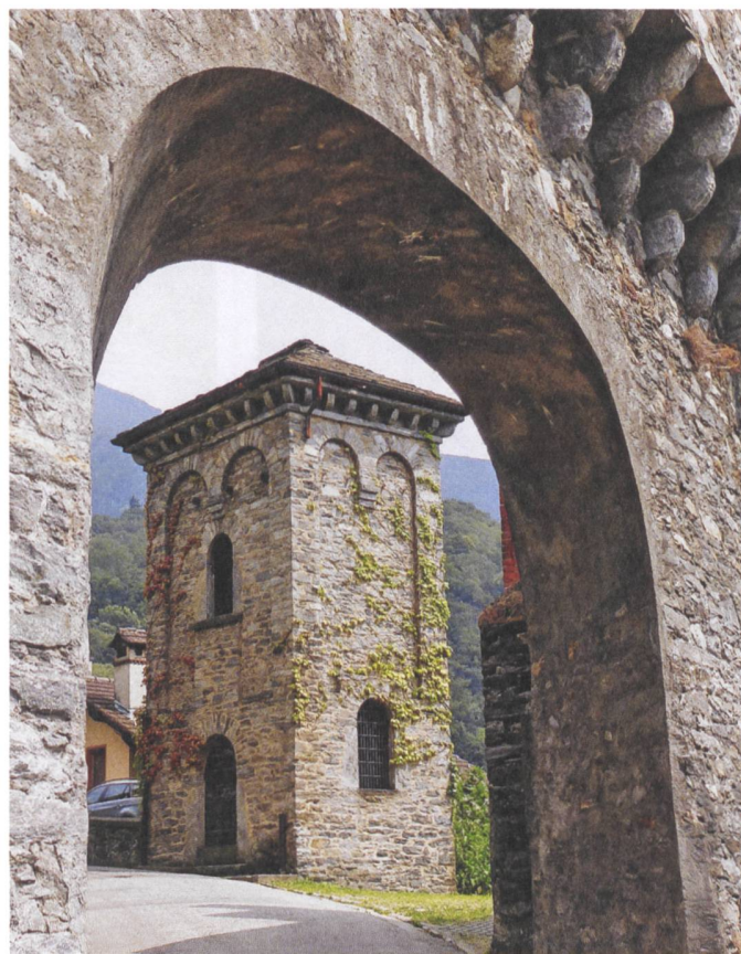
Abb. 5: Einer der vielen Tessiner Steintrafos fügt sich bestens in den historischen Bestand ein, hier in Bellinzona.
