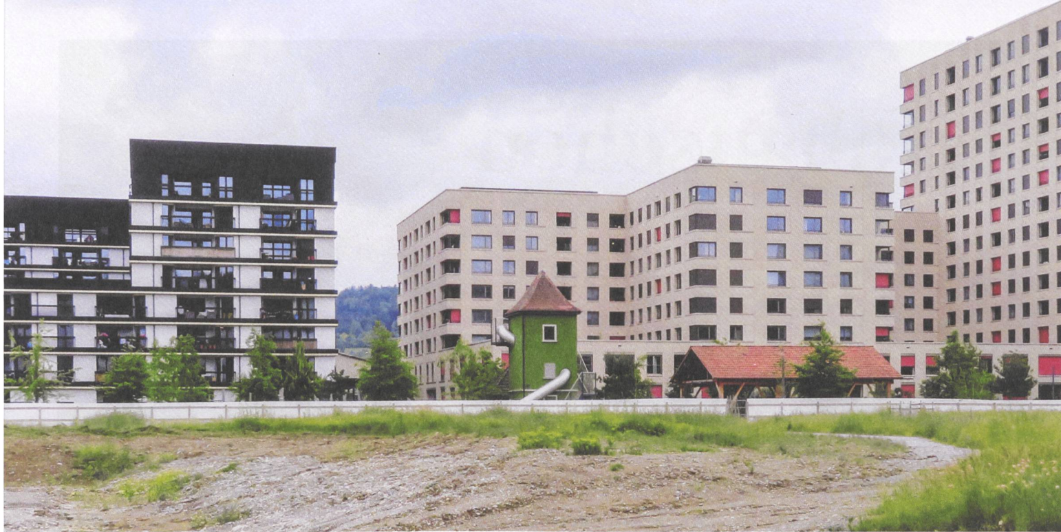
Abb. 3: Im Wandel der Zeit: 2024 ist das Schlieremer Zeltdach-Trafohäuschen grün geworden und gehört zum Spielplatz einer neuen Wohnüberbauung. © Yvonne Scheiwiller
