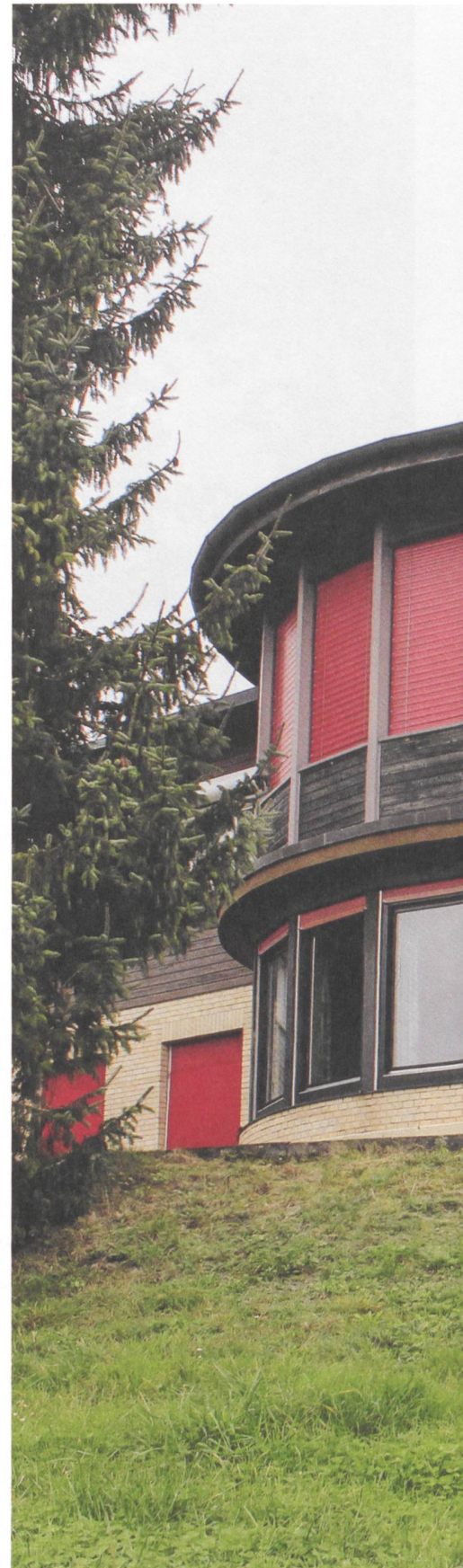
Abb. 3: Das Kinderheim Mümliswil heute: umgebaute Terrasse über dem Speisesaal im Erdgeschoss. © Maria Kouvari
