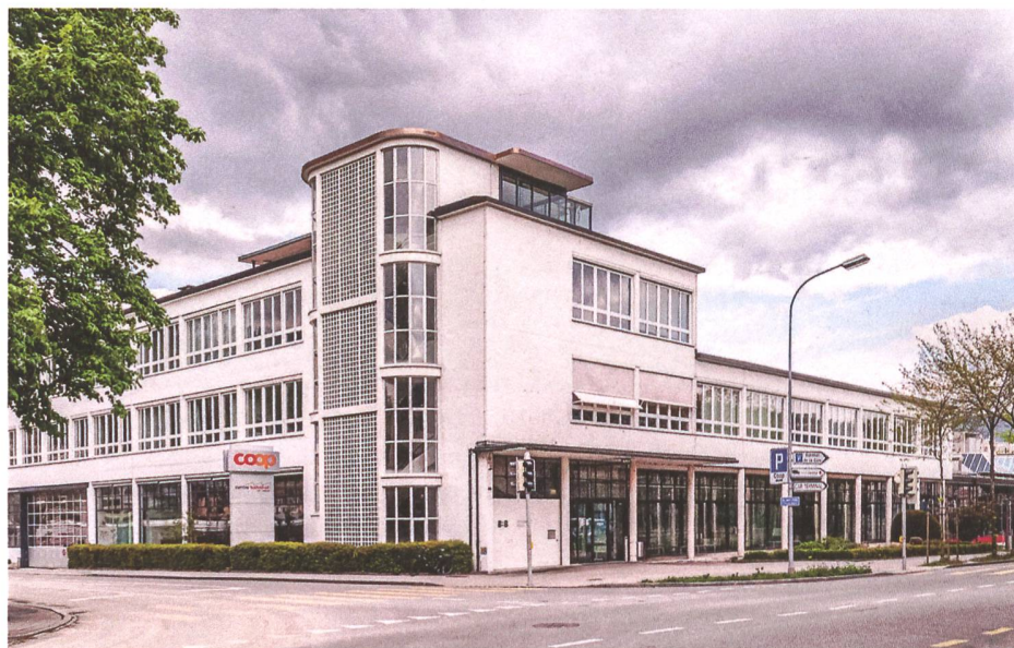
Abb. 3: Das 1936 von Rudolf Steiger erbaute General-Motors-Montagewerk in Biel ist ein Zeuge des Neuen Bauens. Verwaltungstrakt mit Treppenturm, heute genutzt von der Schule für Gestaltung Bern und Biel.
