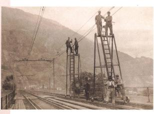
Abb. 4: Elektrifizierung am Gotthard auf der Strecke Faido-Lavorgo, Bahnarbeiter bei der Installation von Fahrleitungen, ca. 1921. © SBB Historic, F\_110\_00008\_042
