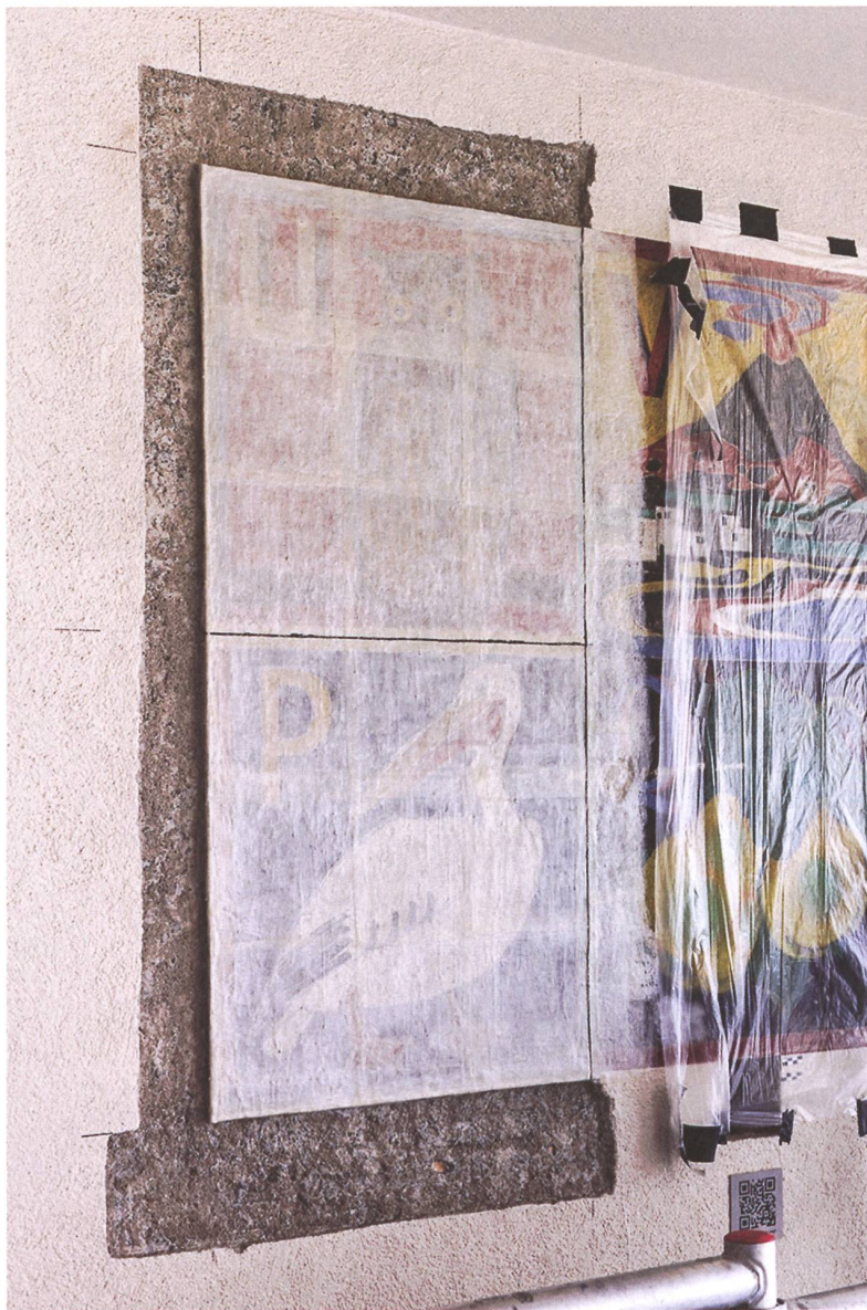
Abb. 6: Bildfelder U und P mit aufliegendem Facing und Reduzierung des umgebenden Wandverputzes fürs Anlegen der Säge.
