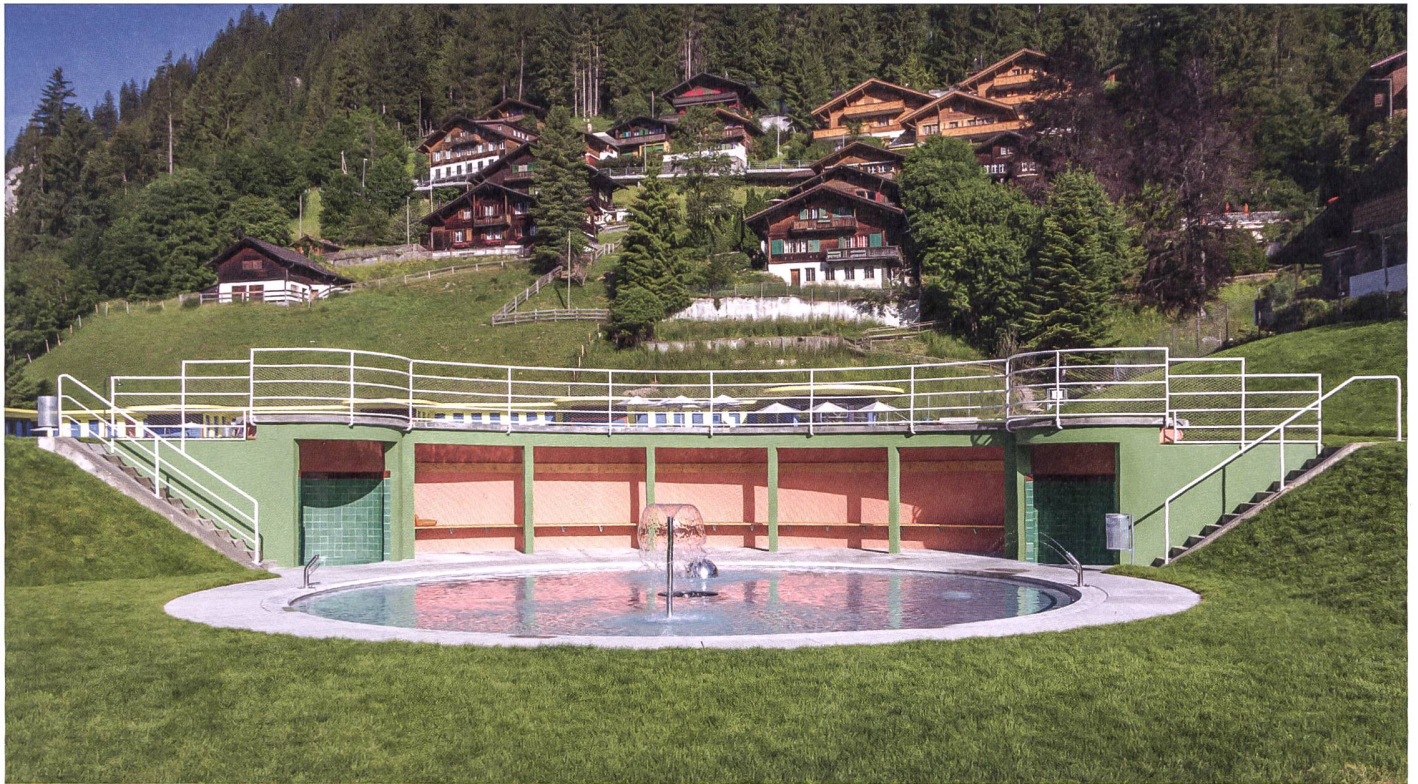
Der Laubengang beim kreisrunden Kinderbecken war zwischenzeitlich zugemauert. Nun ist die Umkleidezone wieder offen.
