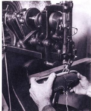
Abb. 4 und 5: Mensch und Maschine. Je nach Modell waren für die Herstellung eines Schuhs 100 bis 200 Arbeitsschritte nötig. Für fast jeden Schritt gab es eine Maschine und eine Fachkraft für die Bedienung. Jedes Werkstück wurde einzeln bearbeitet. © Sammlung Bally Schuhfabriken AG
