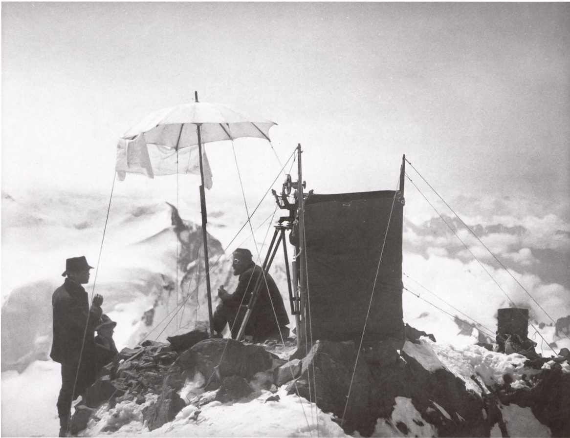
Vermessungsingenieure ganz oben: Signalstelle Piz Bernina, Versicherungsarbeiten und Instru- mentenaufstellung, 1914.
