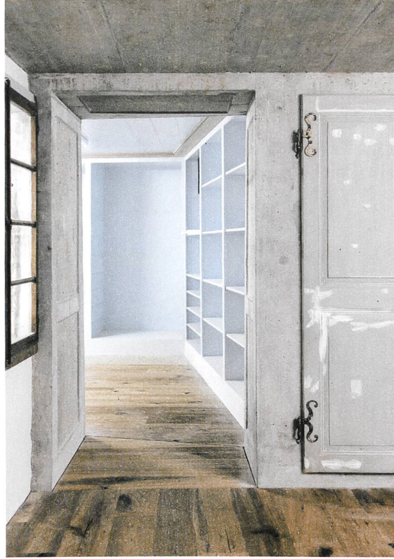
Blick ins Ateliergeschoss. Auf der neuen Betonwand ist eine alte Tür rahmenlos aufgesetzt. © Robert Swierczynski
