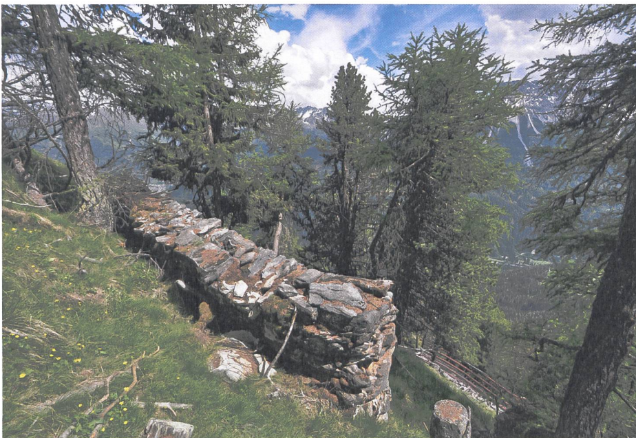
Abb. 2: Steht heute noch: die erste technische Verbauung von 1868 auf der Motta d'Alp in Martina (GR). © Foto: S. Margreth
