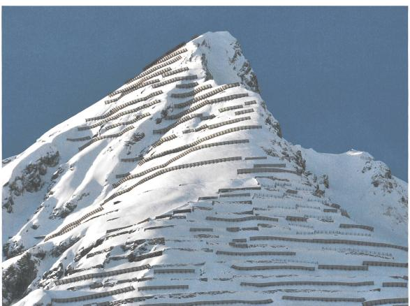
Abb. 4: Landschaftsprägend: Im Lawinenanrissgebiet am Schiahorn oberhalb Davos (GR) stehen insgesamt rund 10 km Stützwerke und Mauern. Die ersten Mauern wurden 1920 aus Steinen erstellt, die neusten Stützwerke aus Stahl können eine bis zu 5 Meter hohe Schneedecke stabilisieren und
