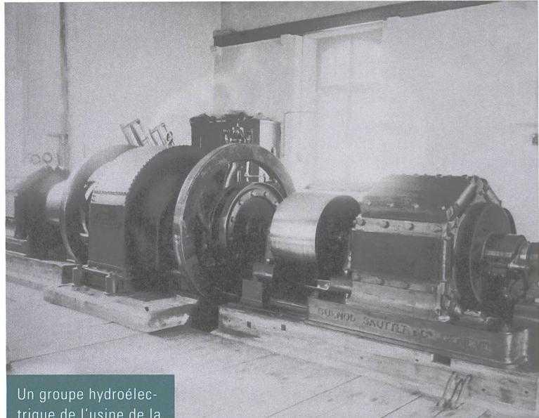
Un groupe hydroélectrique de l'usine de la Rançonnière comportant deux dynamos et une turbine système Girard, photographie anonyme, 1890.
