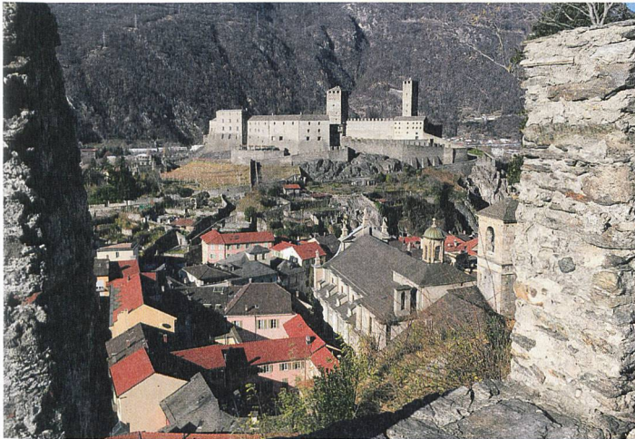
Die Burgen von Bellinzona stehen im Spannungsfeld zwischen Bewahren und Vermarkten.
