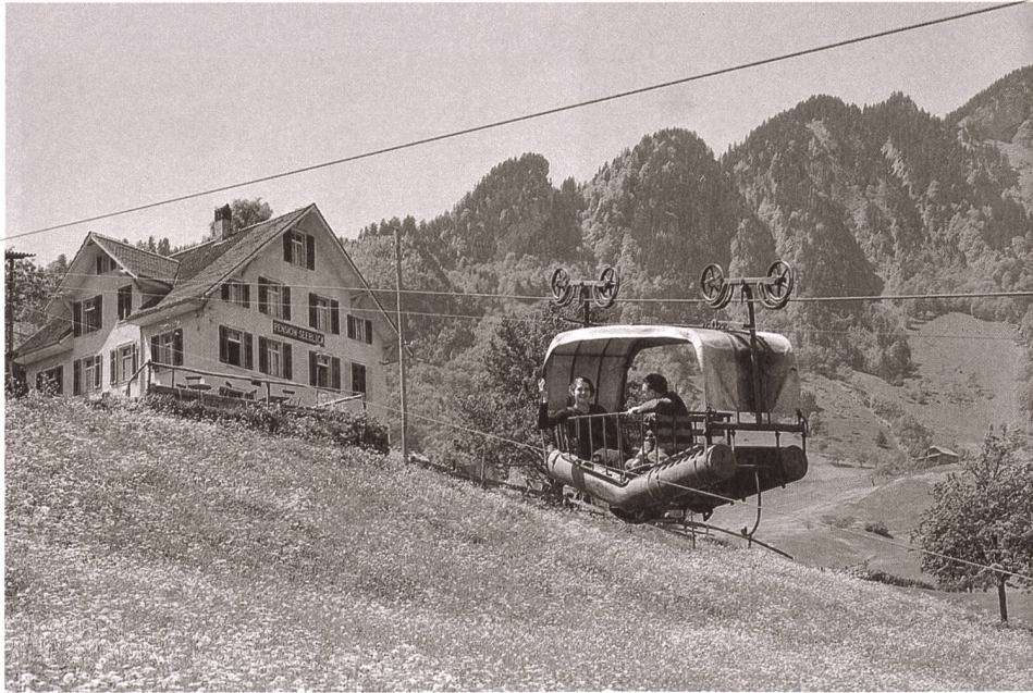
Eine weitere frühe Luftseilbahn mit Wasserballast- antrieb.
