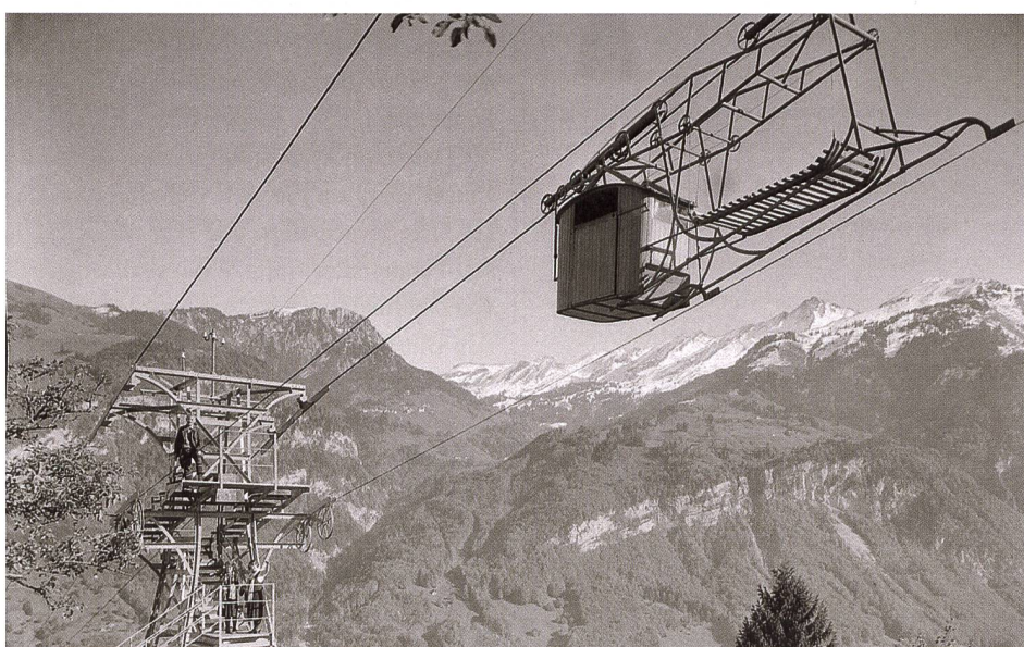
Die Luftseilbahn Dallenwil – Wiesenberg wurde ebenfalls von NSD Niederberger erbaut. Ungewöhnlich ist, das unter der Kabine und Ladebrücke geführte Zugseil. Foto 1935.
