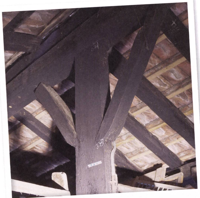
Dachstuhl von 1305 in einem Blockbau in Steinen.
