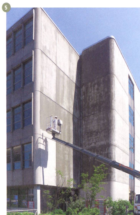
Abb. 5: Lenzburg, Hauptgebäude der Berufsschule: Reinigung der Sichtbeton- fassade, 2015.
